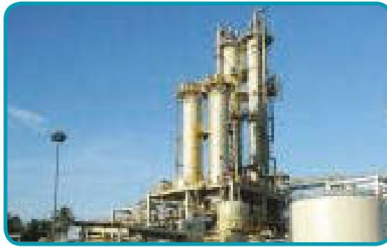
(Sumber: www.arrahmah.com ) Gambar 3.12 Bangunan industri
