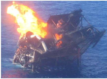
Gambar 11 Blowout yang terbakar pada pemboran lepas pantai
