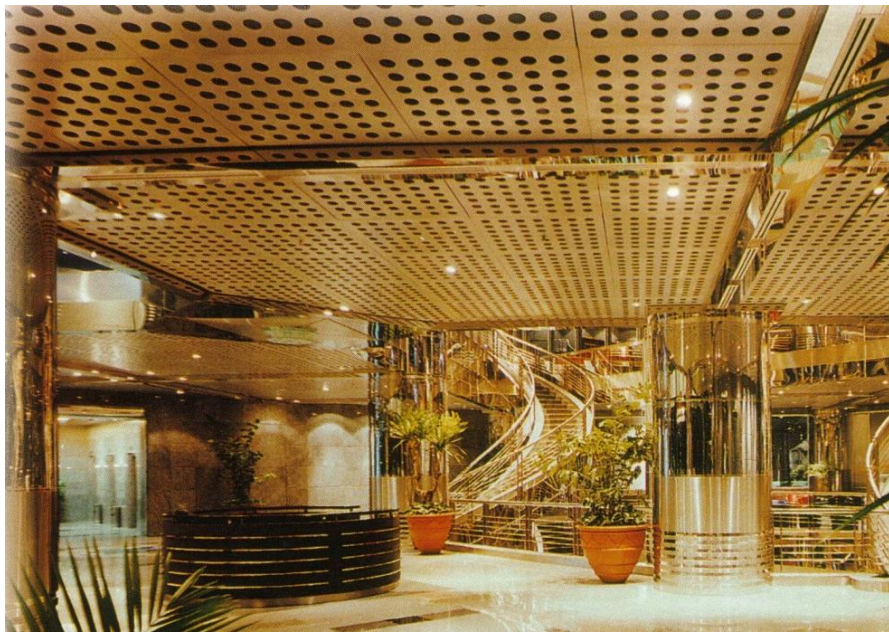
Gambar 3: Plafon terbuat dari lembaran baja bermotif lobang-lobang
