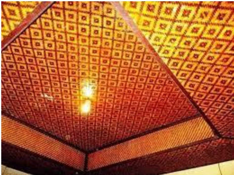
Gambar 1: Plafon terbuat dari material anyaman bambu
