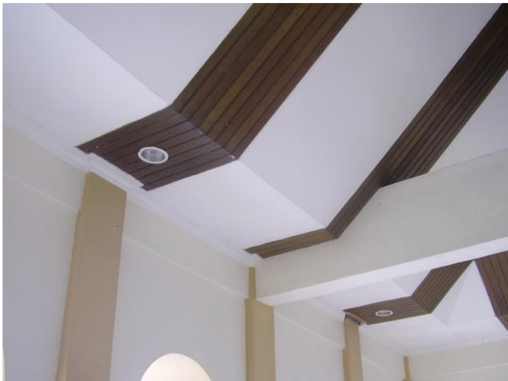
Gambar 10: Plafon yang dibuat dengan kombinasi dua material, lambersering dan mu;tiplek.
