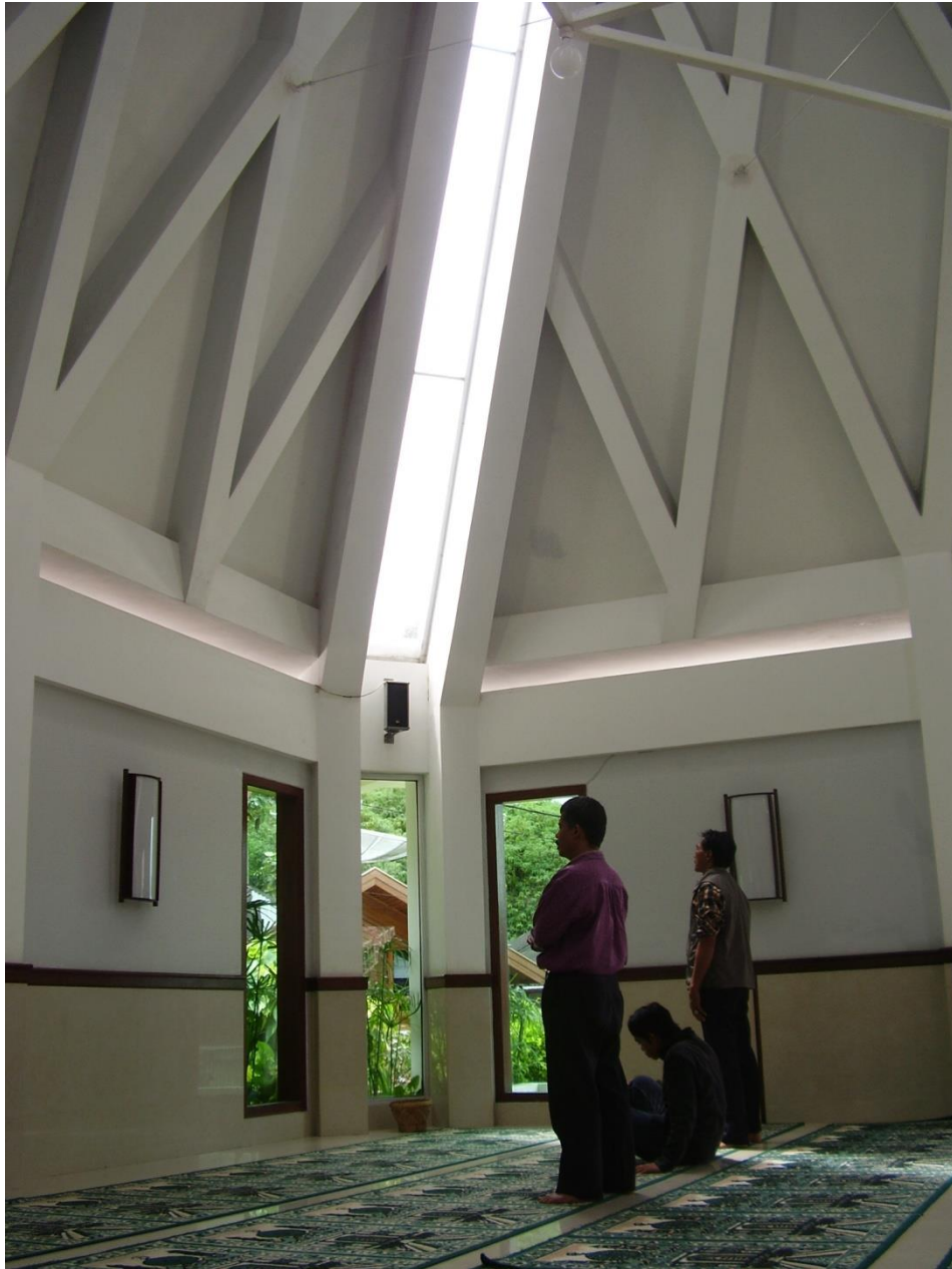
Gambar 11: Plafon beton dengan ventilasi kaca
