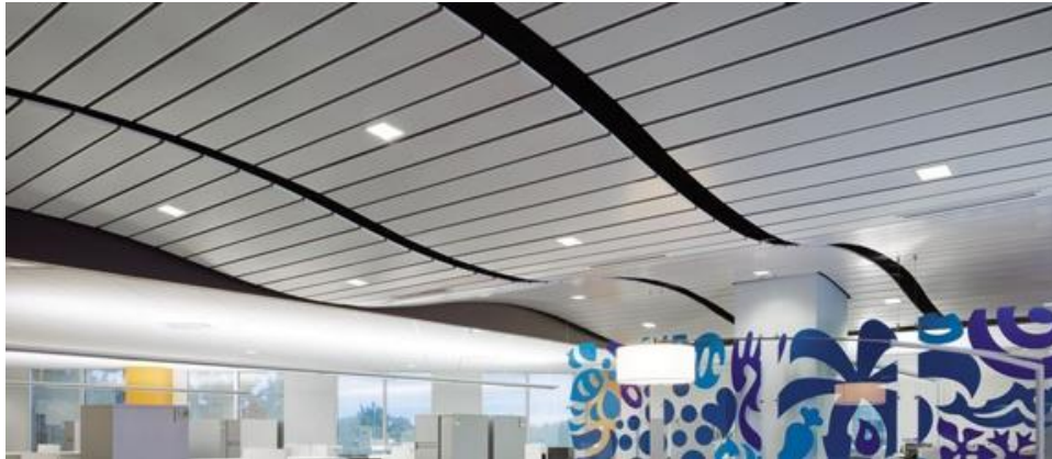
Gambar 9: Disain plafon yang bergelombang dengan bahan gyptone
