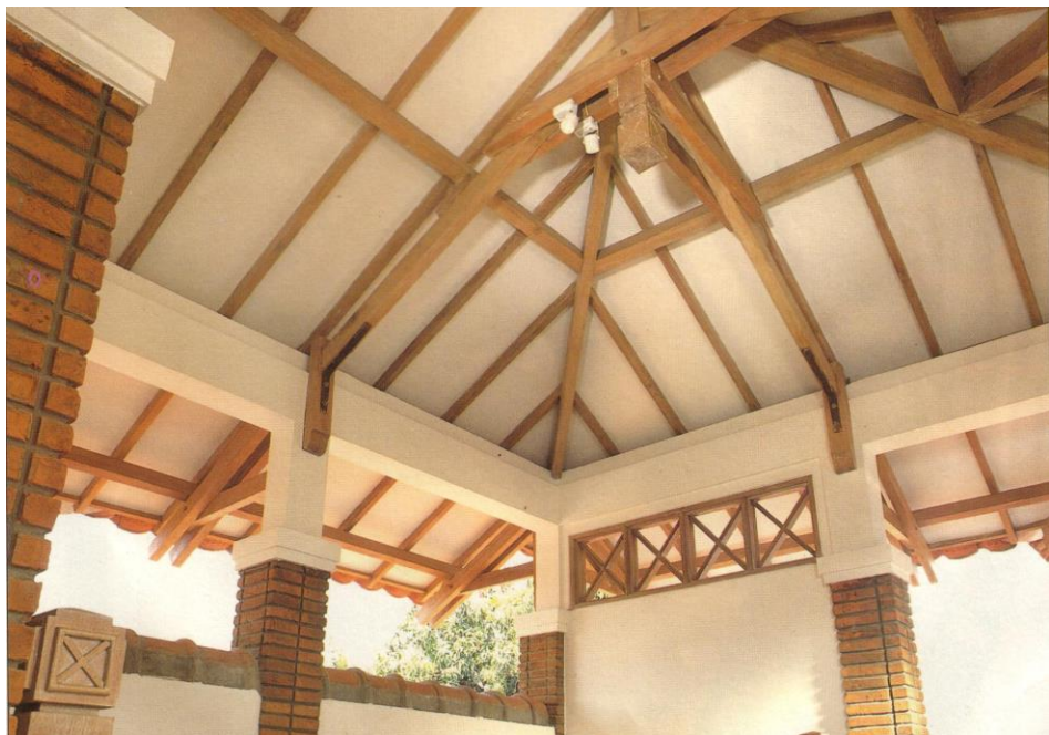
Gambar 2: Plafon triplek/multipleks dengan mengekspos kuda-kuda dan rangka atap.
