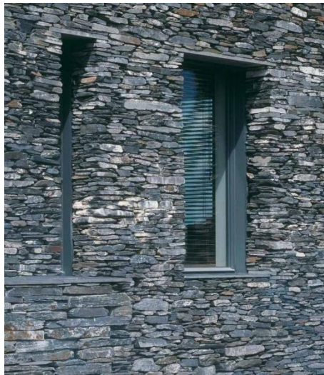
Gambar 34. Pemasangan Ornamen Batu Alam Pada Dinding Depan Rumah Sumber: Desain-Desain Rumah, 2013
