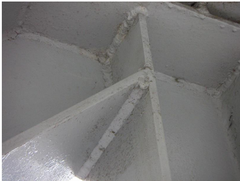
Gambar 1.18 Pengelasan pada Sambungan Profil Baja
