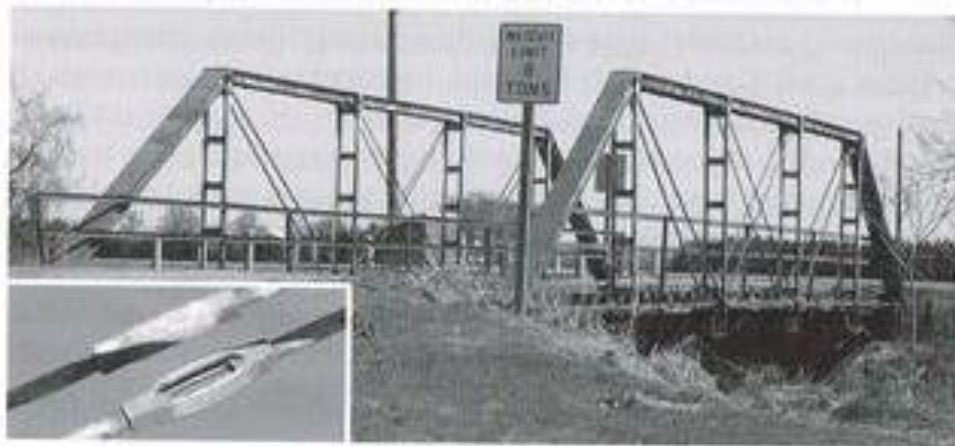
Gambar 2.2 Batang tarik dengan turn - buckle pada jembatan Lincoln, Nebraska (Sumber ; http://commons.wikipedia.org/ )
