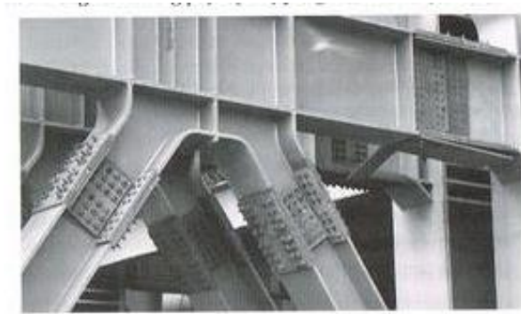
Gambar 2.5 Sambungan Batang Tarik (Sumber ; Tejo dan Mita)
