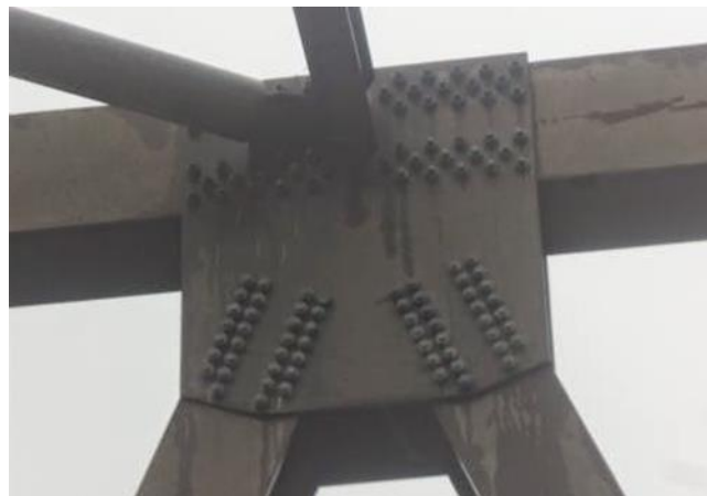
Gambar 2.1. Sambungan struktur baja
