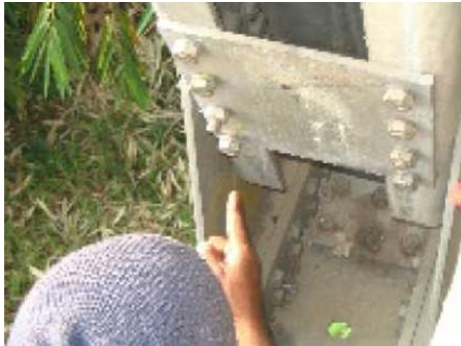
Gambar 8.4 Penggantian elemen profil I terbalik dengan profil kanal ganda pada batang diagonal jembatan rangka baja
