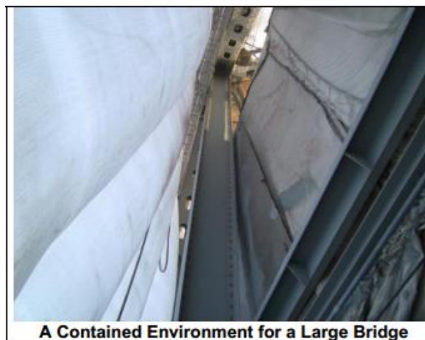
Gambar 8.3. Proses Perlindungan Lingkungan Saat Pengecatan
