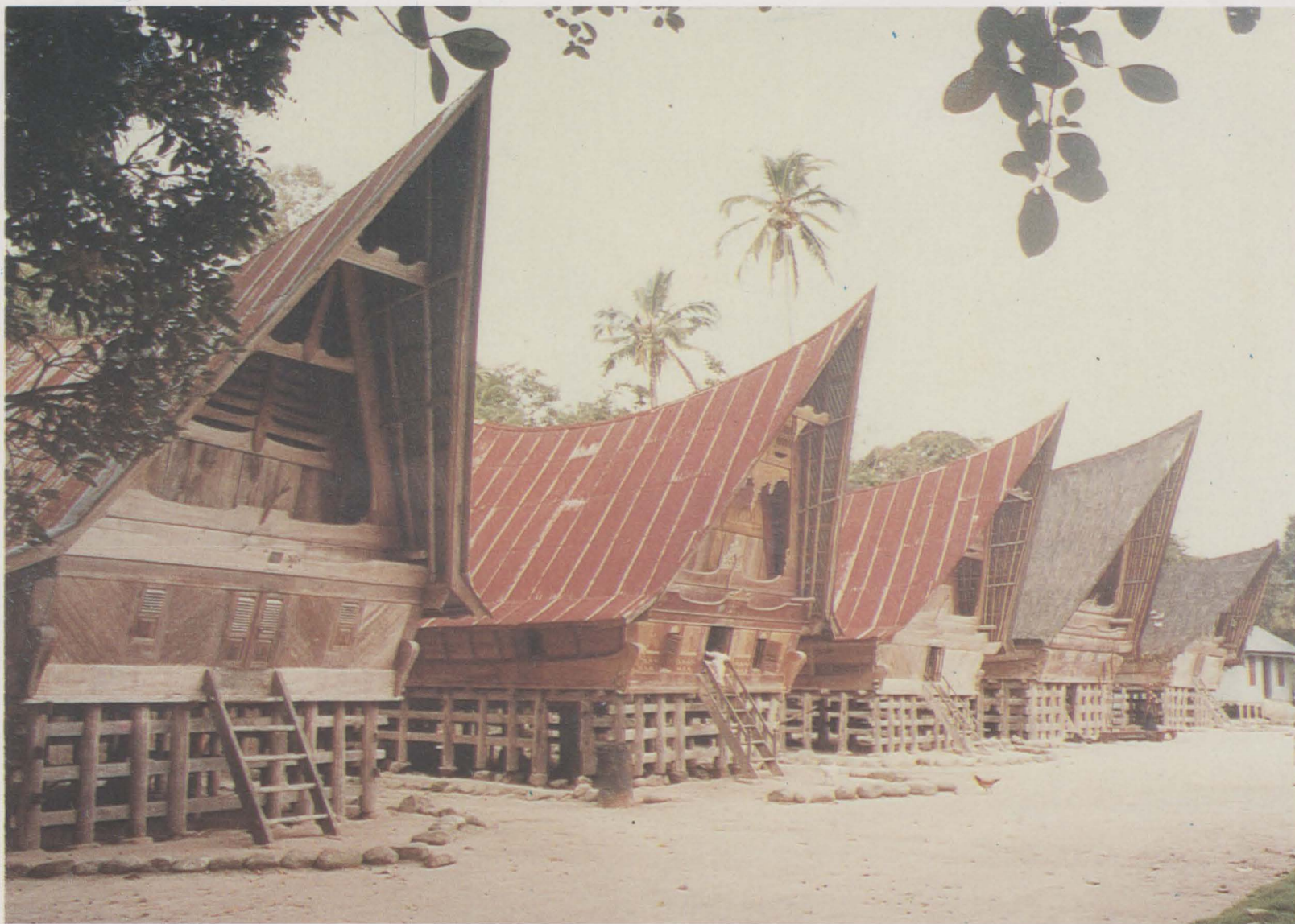
Rumah Adat Batak Toba di Tomok, Samosir. Atap rumah sudah banyak yang diganti dengan atap seng.
