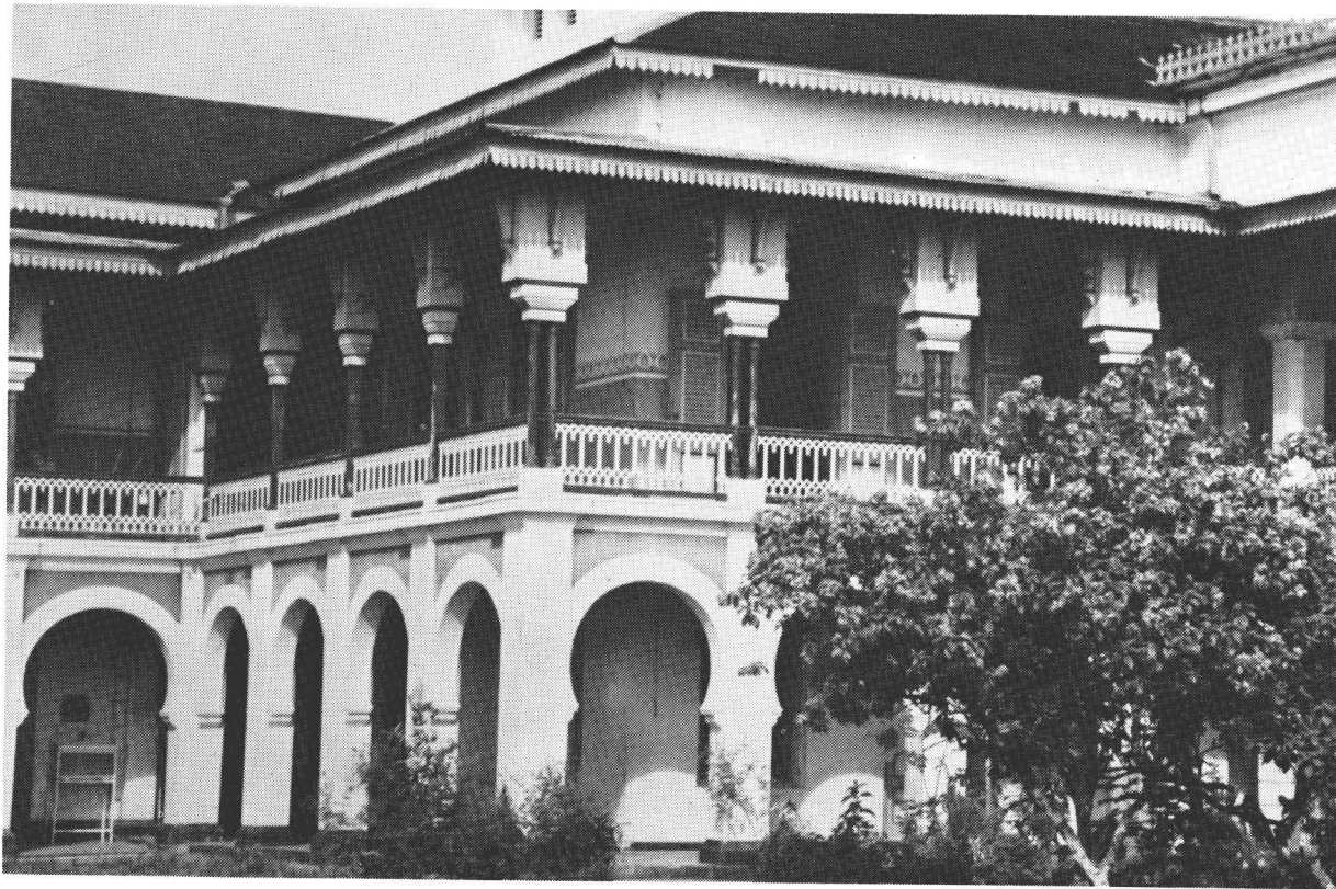
Bagian depan Istana Maimun, bentuk relung-relung sangat mendominasi gaya bangunannya.
