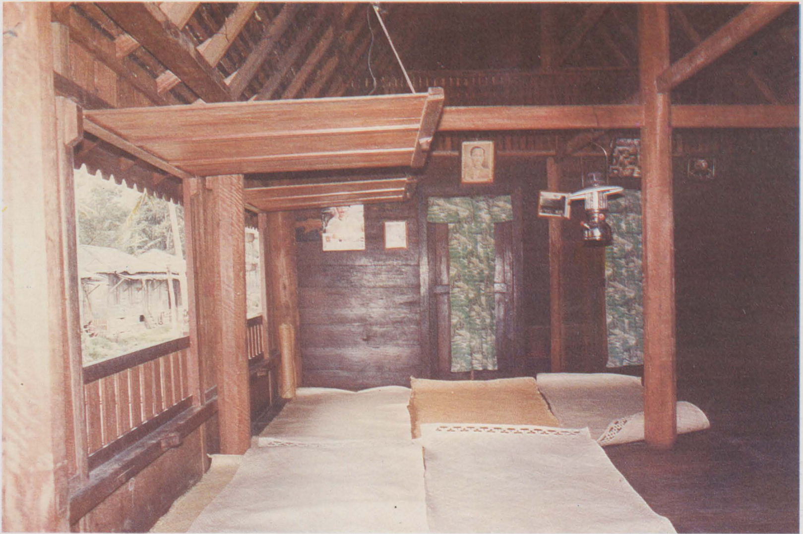
Daun jendela atau tingkap Bagas Godang Pakantan konstruksinya menggunakan engsel kayu.
