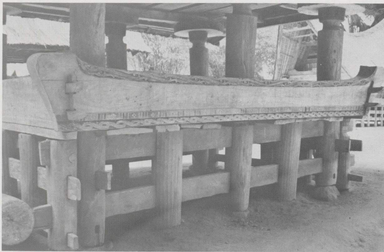
Konstruksi bagian bawah tiang Sopo yang dibuat dengan sistem pasak.
