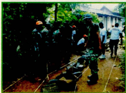
Perbaikan jalan desa yang dilakukan secara gotong royong (PKBM Agro Wilis)
