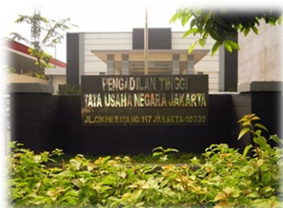
Gambar 8. Gedung Pengadilan Tinggi Tata Usaha Negara
