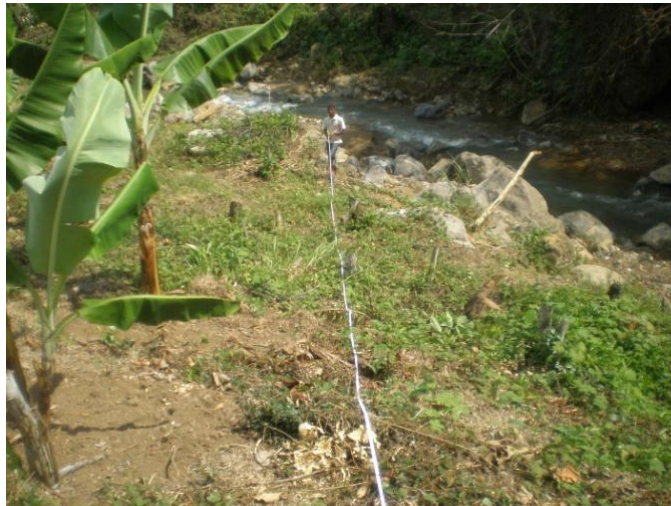
Gambar 7.2. Pengukuran Head menggunakan meteran
