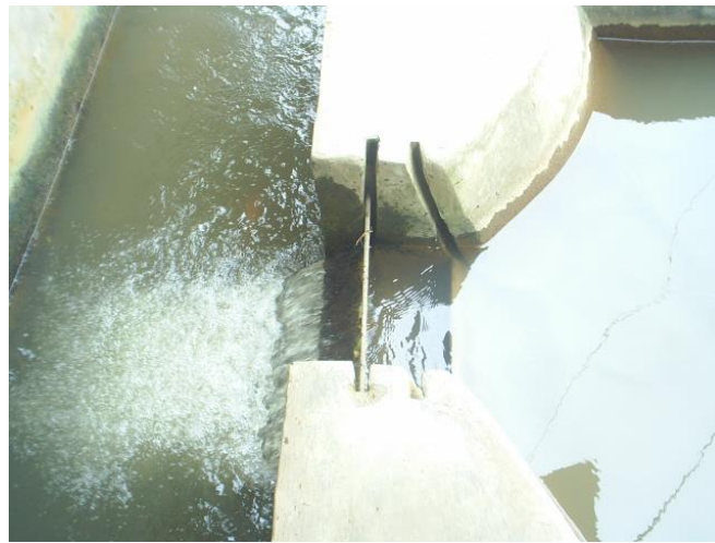
Gambar 11. Pintu pengeluaran air tipe Monik.
