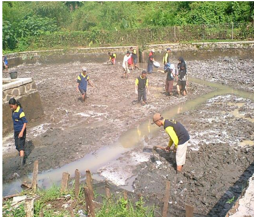
Gambar 42. Mengapur tanah dasar kolam
