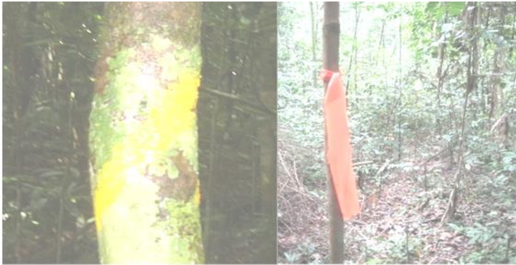
Gambar 4. Pemberian Tanda Trace Jalan
