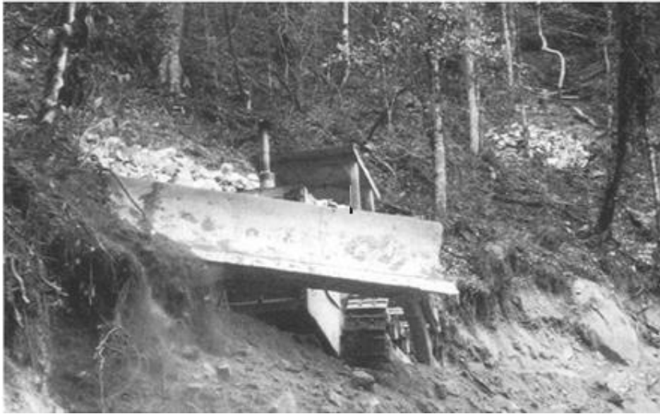
Gambar 31. Traktor Buldoser Menggali Matereial Untuk Menimbun Lapisan Jalan
