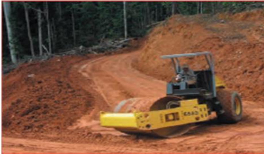
Gambar 36. Pemadatan Jalan Dengan Menggunakan Bomag Conveyer
