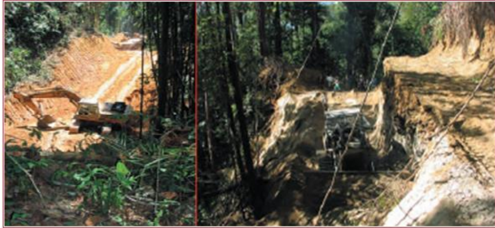
Gambar 33. Bahkan Pada Daerah Yang Landai Excavator Sebagai Mesin Pembuatan Jalan Utama, Bisa Mengungguli Bulldozer Dalam Menghasilkan Sub-grade Yang Lengkap Dengan Parit Di Pingir Jalan Dan Dampak Lingkungan Yang Minimal.
