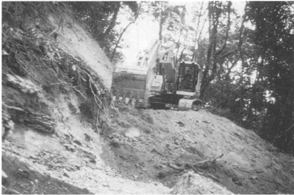
Gambar 32. Pembuatan Jalan dengan Menggunakan Alat Exavator
