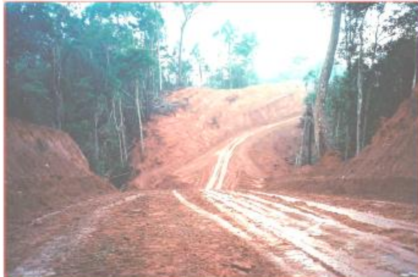
Gambar 26. Slope Staking Secara Signifikan Mengurangi Kegiatan Mesin Pada Punggung Bukit.
