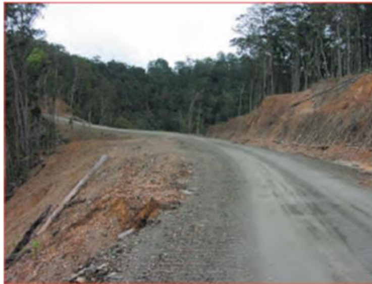
Gambar 37. Jalan Yang Di Balast Dan Dipadatkan Dengan Baik. Perhatikan Puing Kayu Yang Diletakan Di Pinggir Jalan Untuk Mengurangi Erosi.
