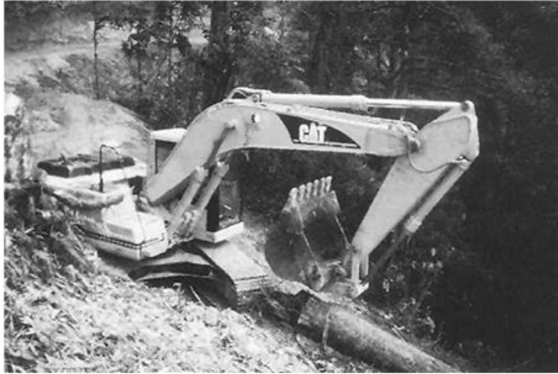
Gambar 28. Pembuatan Jalan Dengan Excavator
