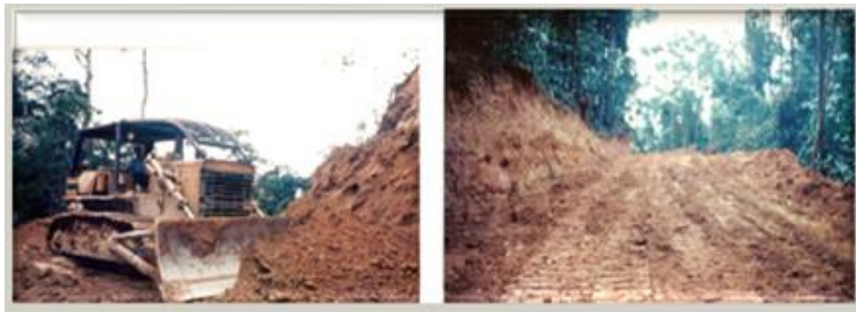
Gambar 34. Pembuatan Jalan Mengikis Tebing Dengan Menggunakan Buldoser D55
