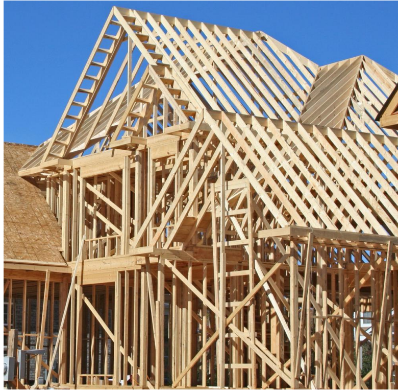
Gambar 23. Konstruksi rumah berbahan kayu
