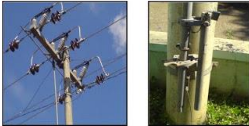
Gambar 8. Air Break Switch dan Handle ABSW
