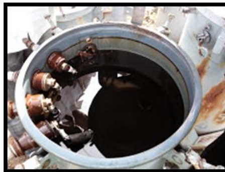
Gambar 7.40 Minyak Trafo
