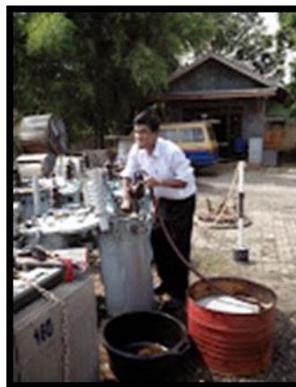
Gambar 7.41 Penyedotan Minyak Trafo
