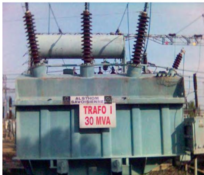
Gambar 4.20 Transformator daya GI konvensional
