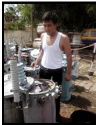
Gambar 7.43 Finising Pengngantian Minyak Trafo siap dipasang lagi, dan life time trafo bisa bertambah dengan digantinya minyak trafo
