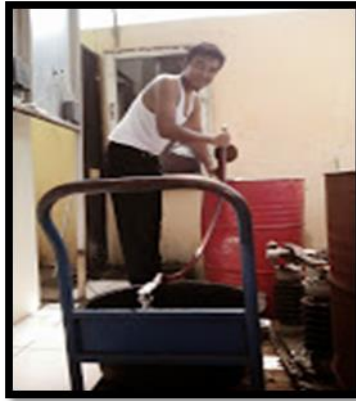
Gambar 7.42 Penggantian minyak Trafo Dengan yang Baru
