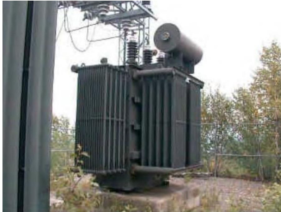
Gambar 4.27 Trafo Pemakaian Sendiri (TPS)
