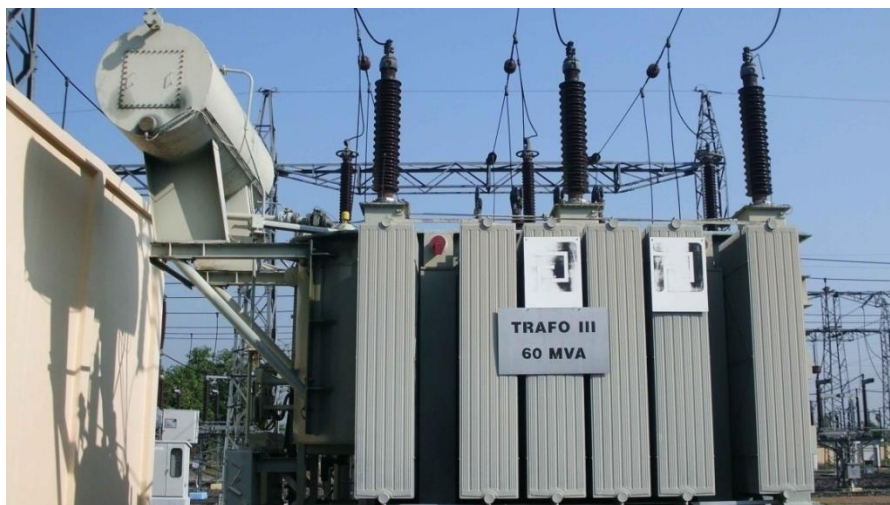
Gambar 3.10 Transformator Gardu Induk
