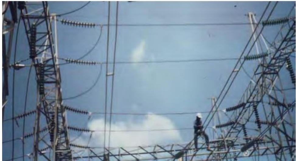
Gambar 4.28 Rel ( BusBar) pada GI Konvensional.
