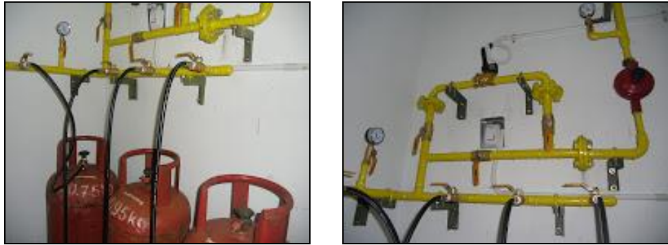
Gambar 34. Tabung Gas Diletakkan Di Luar Area Dapur
