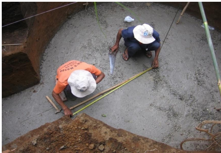
Gambar 54. Menggambar lay out digester pada pondasi
