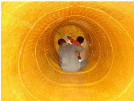
Gambar 35. Melubangi penutup tangki pencerna
