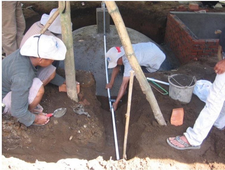
Gambar 144. Penggalan tanah untuk kotak water drain
