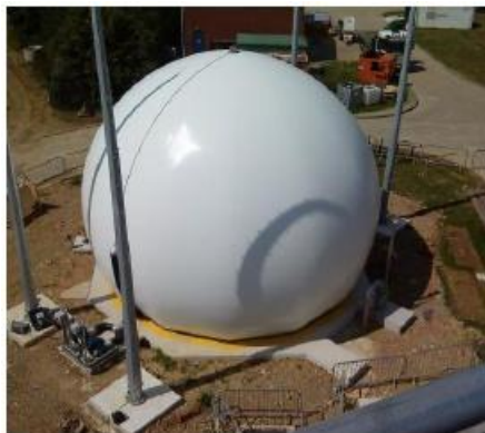
Gambar 14. Contoh reaktor biogas (Swedia)
