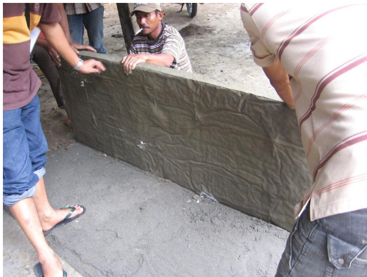
Gambar 105. Pemeriksaan bagian bawah plat penutup Outlet
