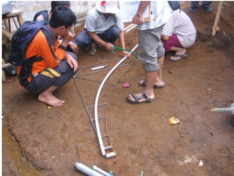
Gambar 89. Menyiapkan mal besi sebagai acuan pengecoran
