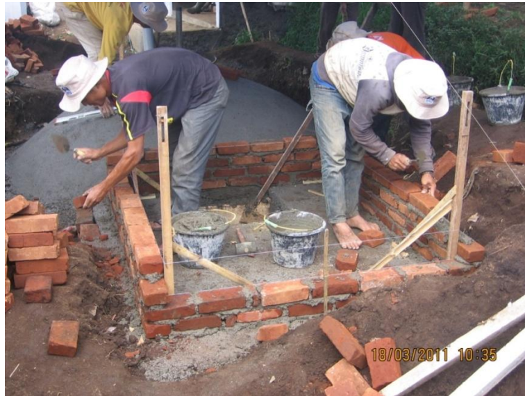
Gambar 118. Pekerjaan pasangan bata dinding Outlet
