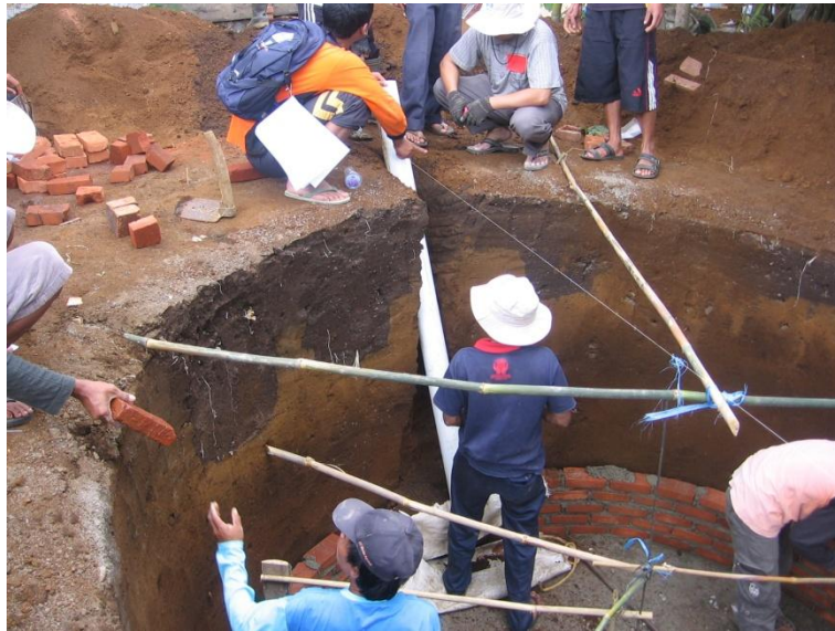
Gambar 63. Penyetelan pipa Inlet
