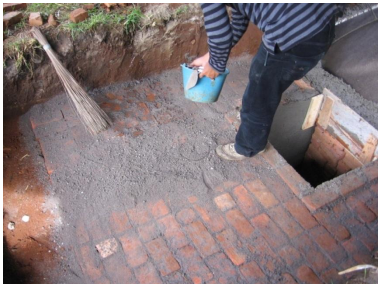
Gambar 113. Penghamparan pasir untuk mengisi celah antara bata
