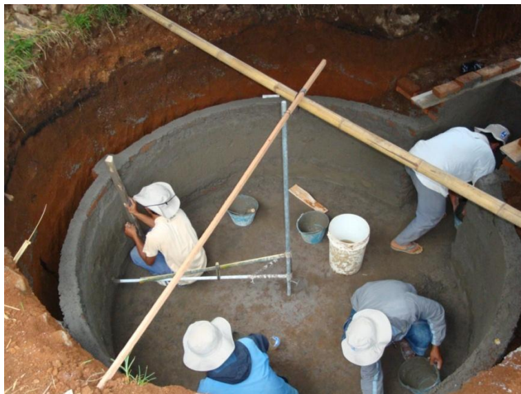
Gambar 68. Pekerjaan pemlesteran tangki pencerna
