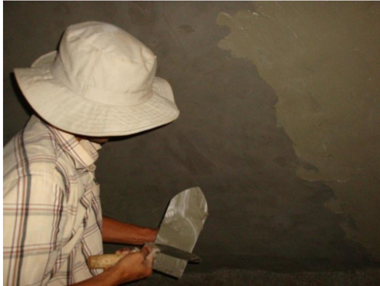
Gambar 174. Gunakan sendok dan roskam untuk plesteran
