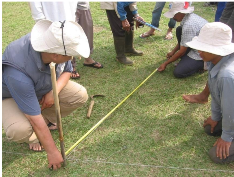
Gambar 186. Mengukur diameter tangki pencerna
