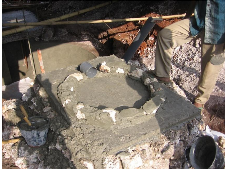
Gambar 136. Memasang batu kali dan pipa saluran
