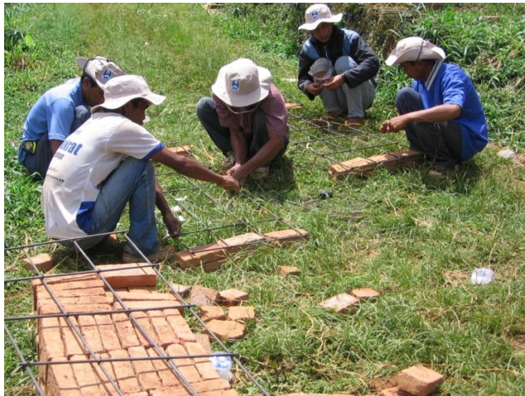
Gambar 100. Pemotongan besi tulangan plat penutup Outlet
