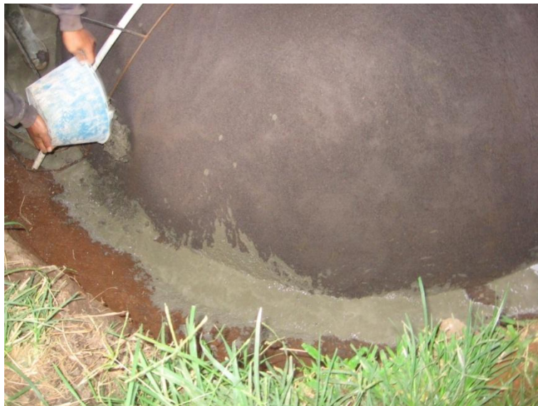
Gambar 90. Mencurahkan adukan dimulai dari bawah cetakan
