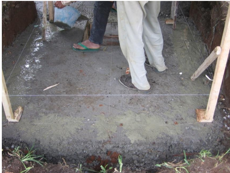
Gambar 116. Pemasangan profil pasangan pada lantai Outlet
