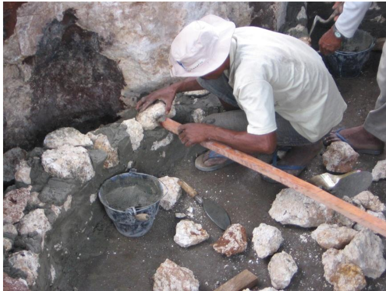
Gambar 77. Dinding tangki pencerna dari pasangan batu kali
