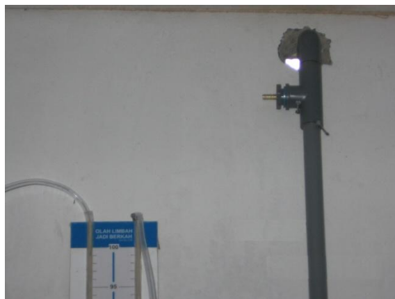
Gambar 161. Pemasangan nipple pada fitting T
