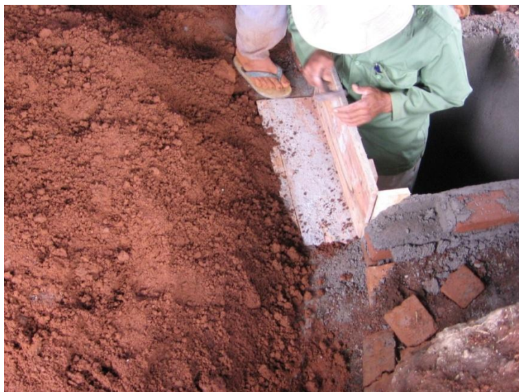
Gambar 84. Pemasangan bekisting untuk balok kubah
