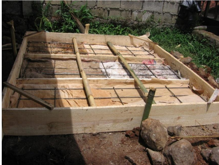
Gambar 101. Memasang besi tulangan plat penutup Outlet
