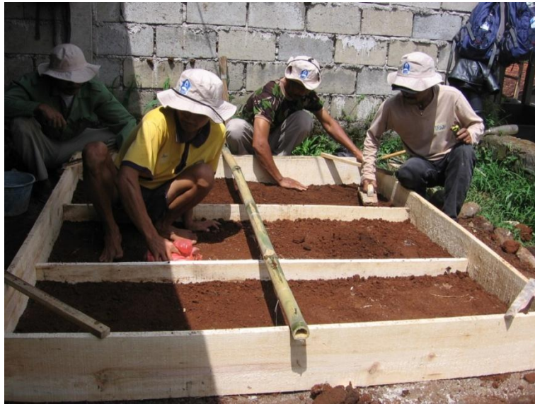
Gambar 99. Memasang bekisting plat penutup Outlet
