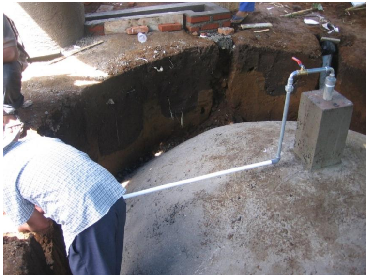
Gambar 143. Pemasangan pipa PVC yang menuju ke dapur
