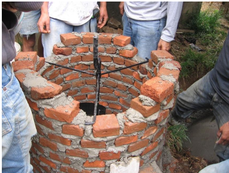
Gambar 131. Setting out mixer pada inlet
