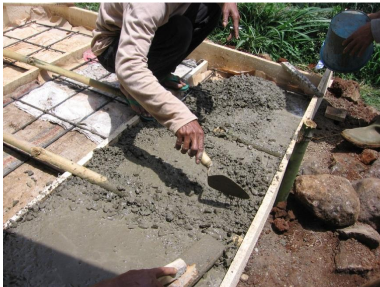
Gambar 102. Pengecoran plat penutup Outlet
