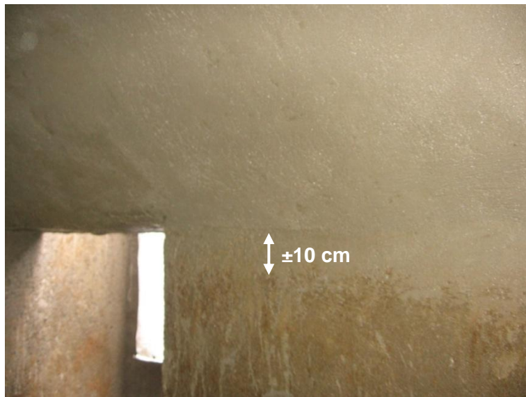
Gambar 172. Finishing lapisan ke 1
