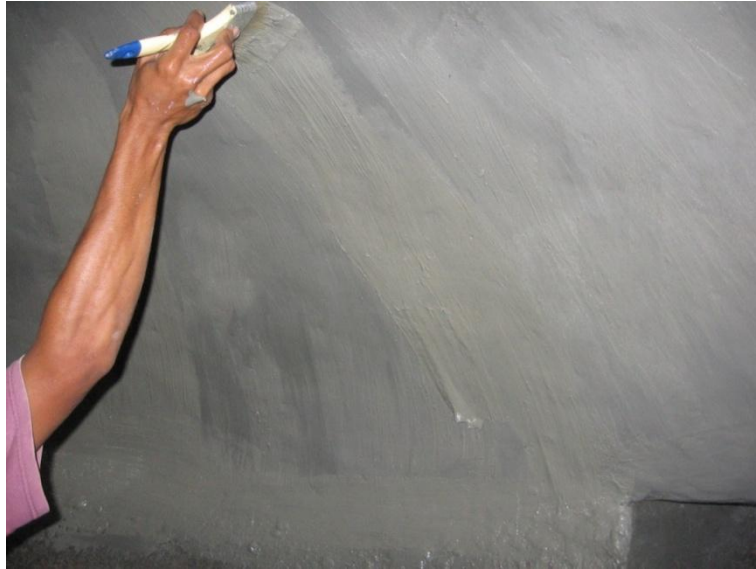
Gambar 178. Gunakan kuas untuk lapisan ke 6
