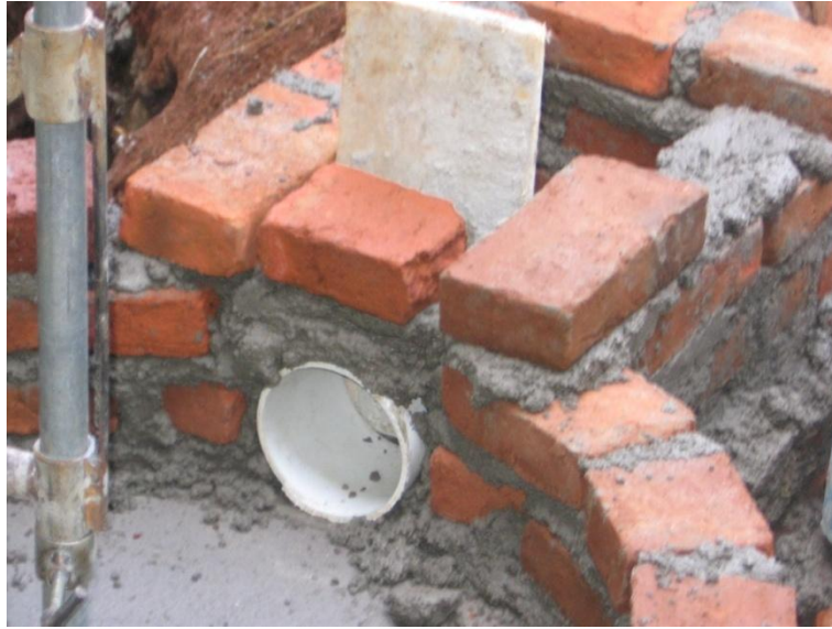
Gambar 130. Memasang kotak pada mulut pipa inlet
