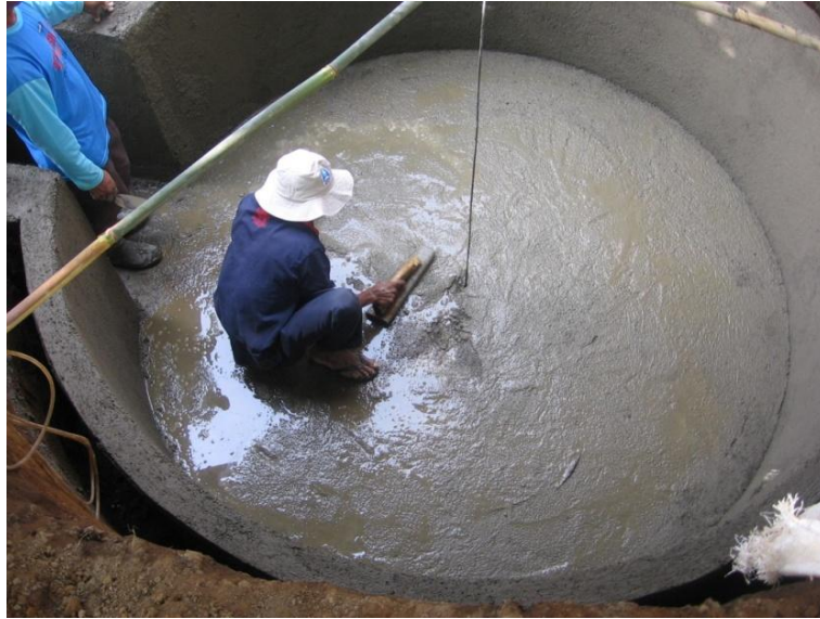
Gambar 71. Pekerjaan finishing lantai pondasi
