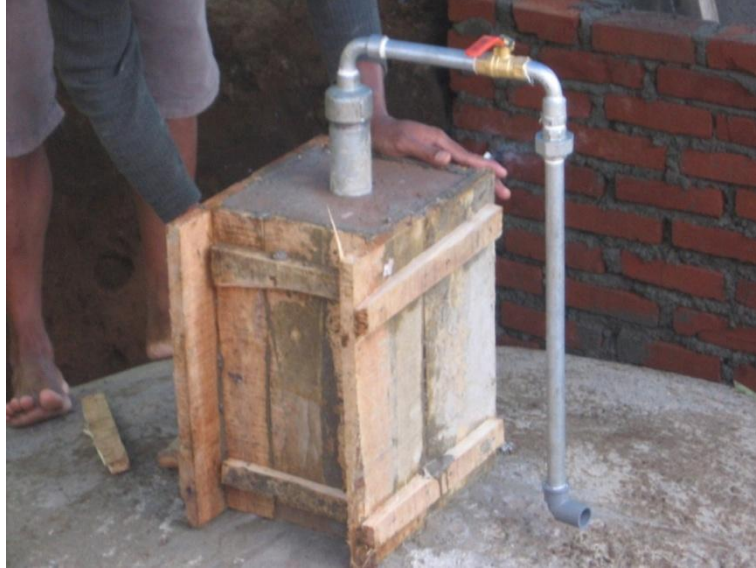
Gambar 142. Pemasangan pipa penyambung
