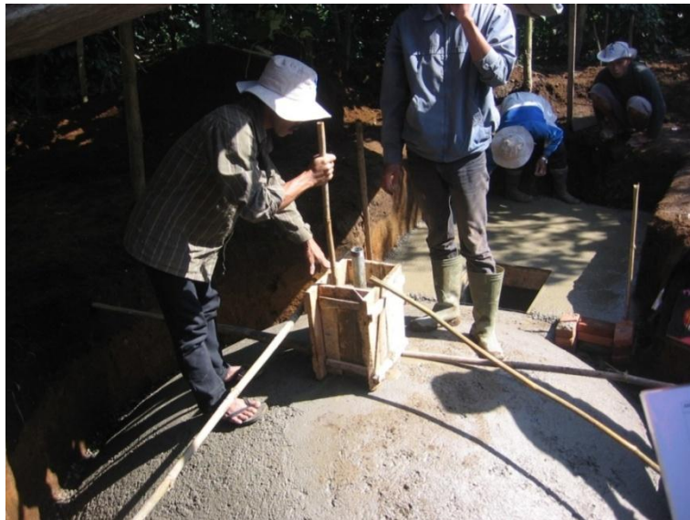
Gambar 110. Pemasangan bekisting turet dari beton
