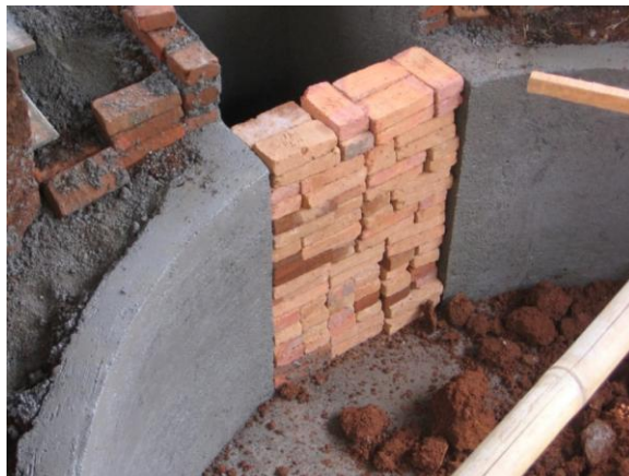
Gambar 82. Pasangan bata pada Manhole
