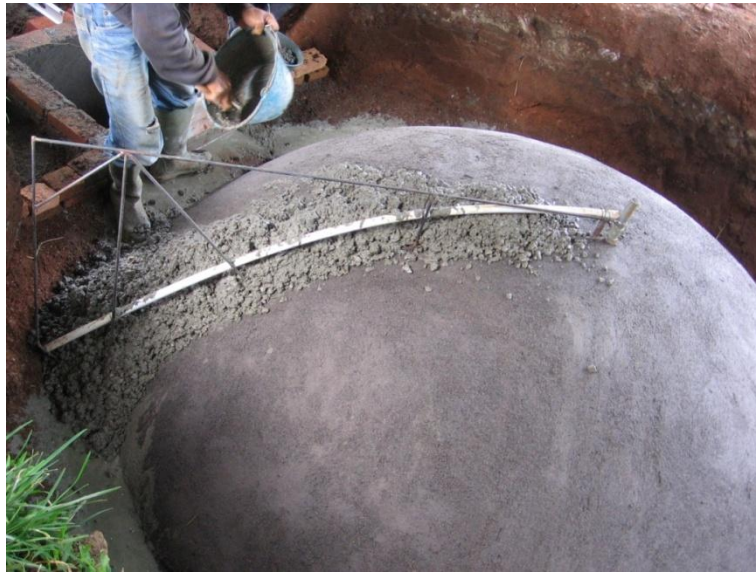
Gambar 91. Mencurahkan adukan beton di bagian atas kubah
