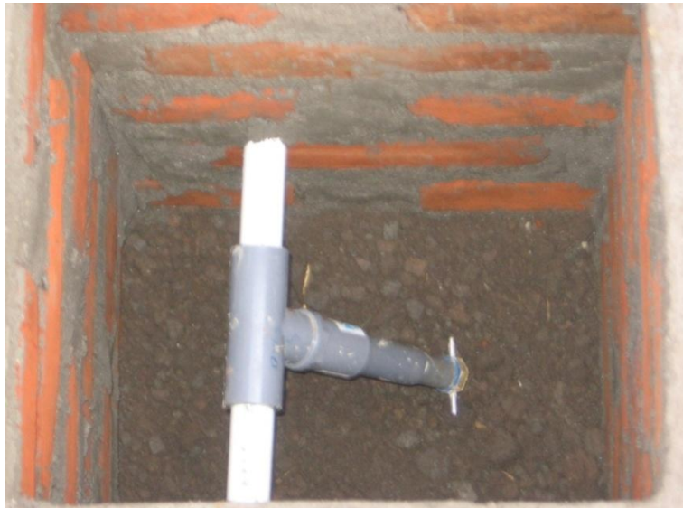
Gambar 146. Water drain harus dipasang dengan posisi miring
