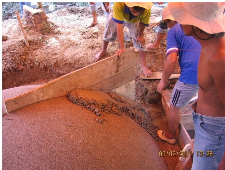
Gambar 98. Penggunaan mal kayu sebagai cetakan beton (2)
