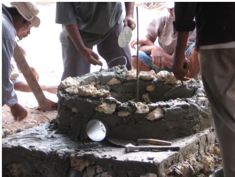
Gambar 137. Memasang dinding inlet
