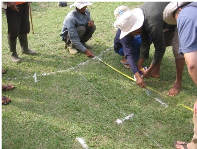
Gambar 188. Mengukur dimensi manhole
