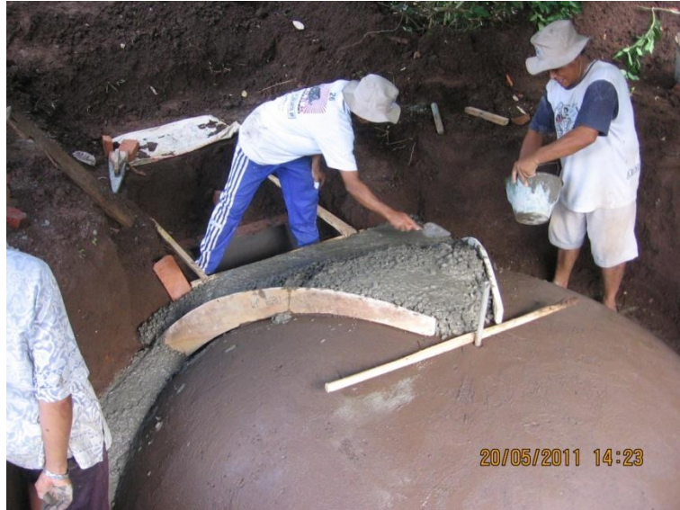
Gambar 97. Penggunaan mal kayu sebagai cetakan beton (1)
