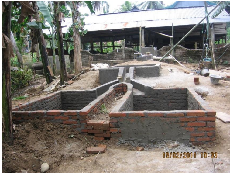
Gambar 153. Contoh slurry pit dari pasangan bata
