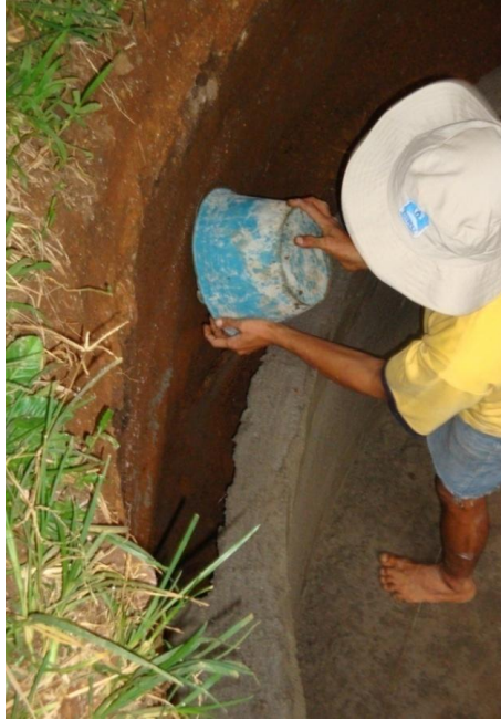
Gambar 69. Pengisian celah dinding tanah dengan tangki pencerna
