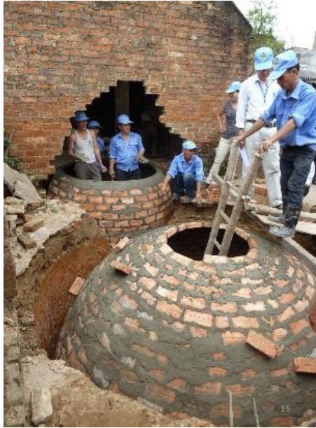
Gambar 22. Pembangunan reaktor biogas (Vietnam)
