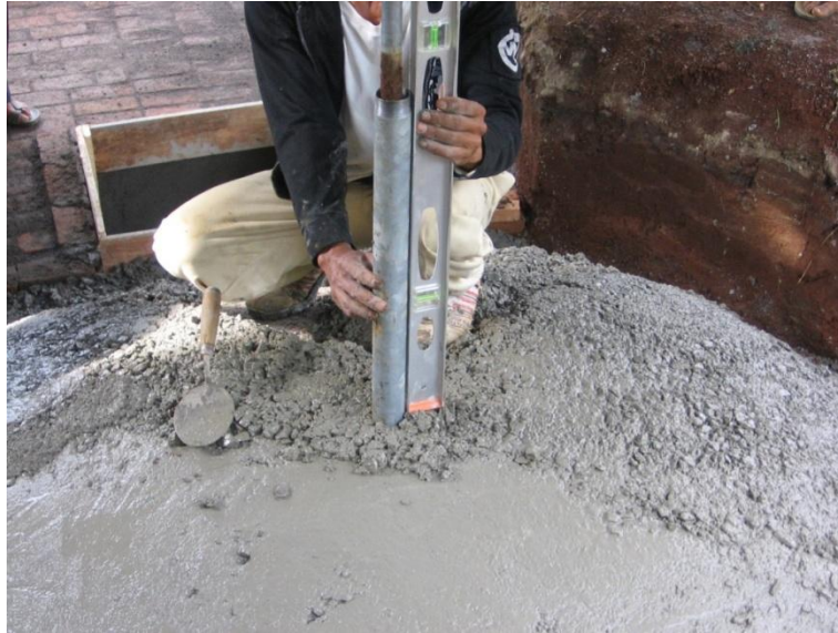
Gambar 95. Pipa gas utama harus dipasang setegak mungkin
