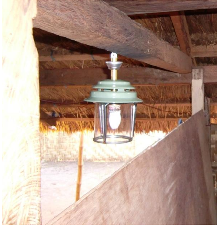
Gambar 171. Contoh lampu biogas di Sumba Barat Daya
