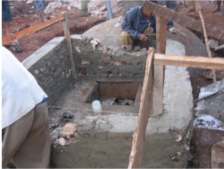
Gambar 122. Outlet dari pasangan batu kali
