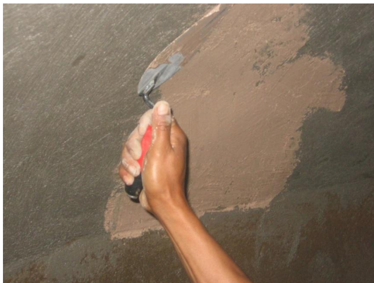
Gambar 177. Gunakan sendok spesi untuk lapisan ke 5
