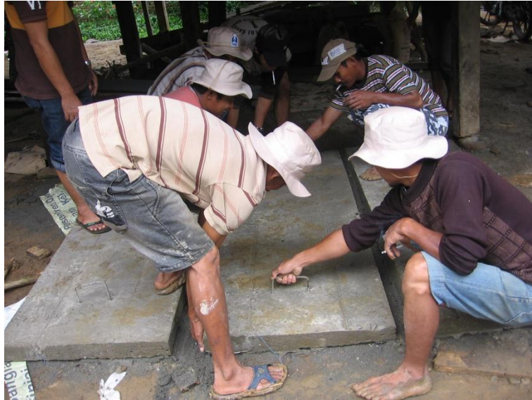
Gambar 104. Proses pengangkatan plat penutup Outlet
