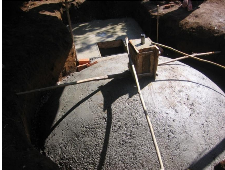
Gambar 111. Turret setelah selesai dicor
