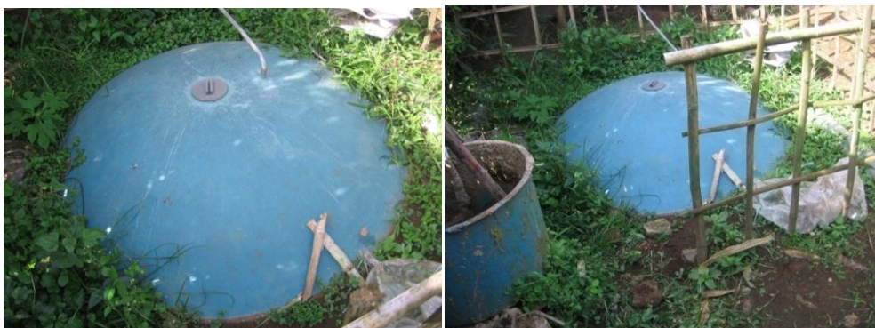
Gambar 29. Reaktor biogas dari bahan fibreglass
