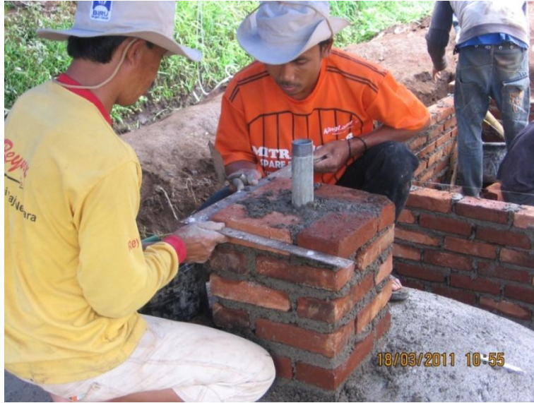
Gambar 107. Pemeriksaan kesikuan pasangan bata
