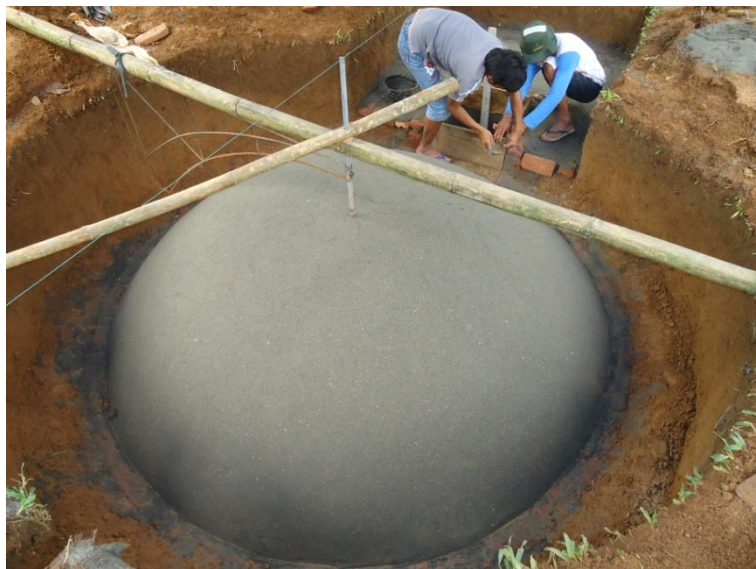
Gambar 88. Cetakan kubah setelah dilapisi pasir
