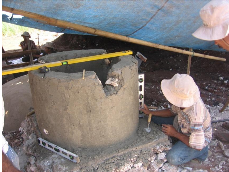
Gambar 138. Melakukan finishing inlet sebelum pemasangan mixer
