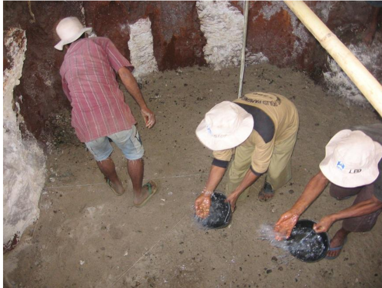
Gambar 51. Memercikkan air agar pasir masuk ke celah batu kali
