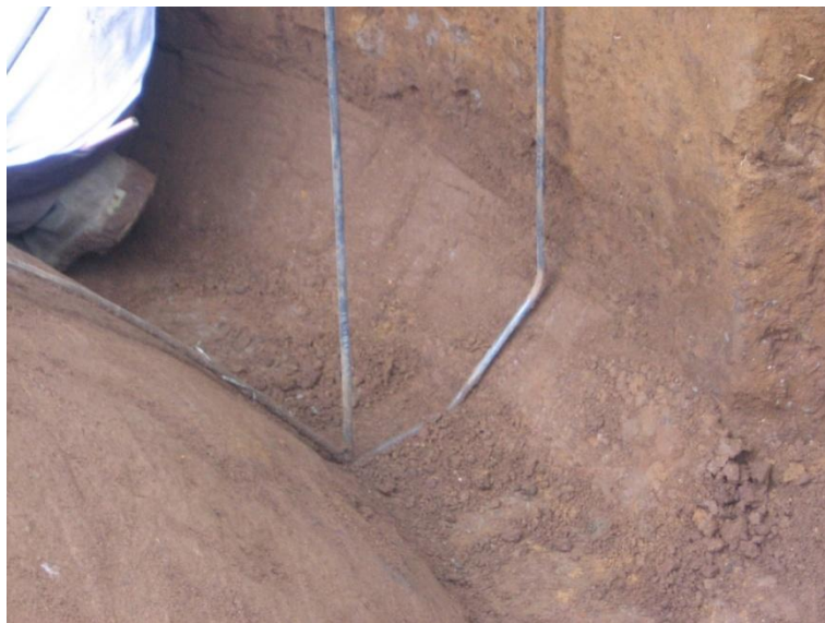
Gambar 86. Pembentukan tepi kubah dengan mal
