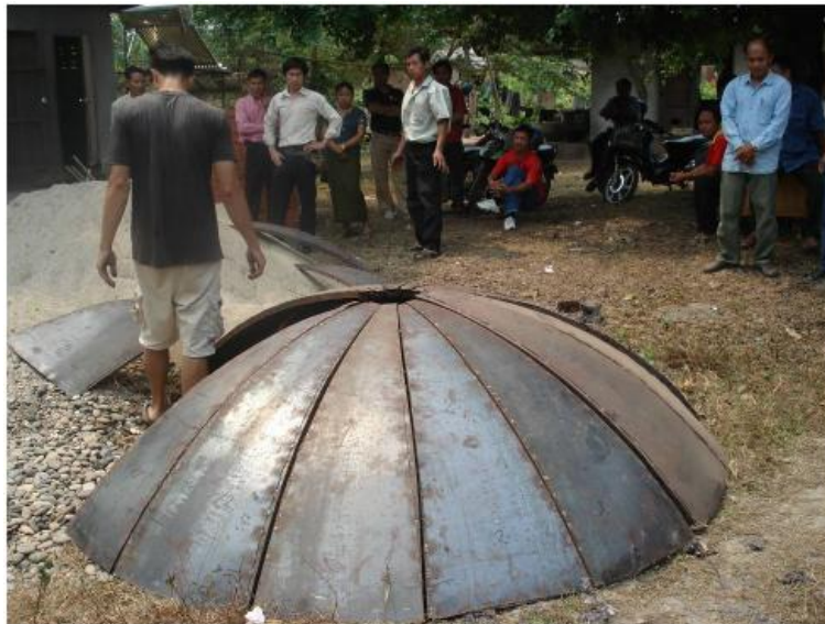
Gambar 79. Contoh cetakan kubah dari plat besi (1)
