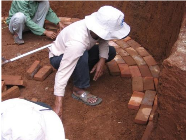
Gambar 47. Menyusun bata untuk lantai kerja
