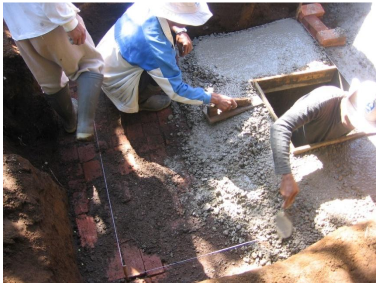
Gambar 115. Pengecoran lantai Outlet
