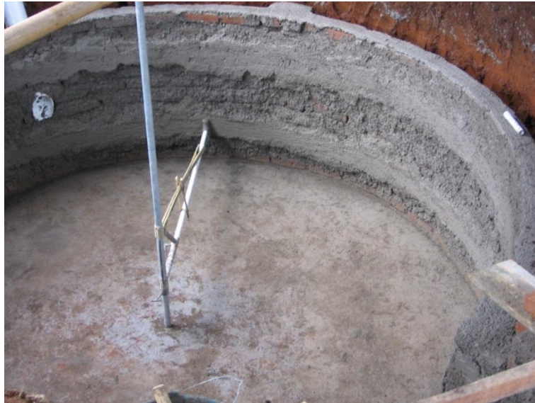
Gambar 67. Pembuatan jalur untuk kepala plesteran
