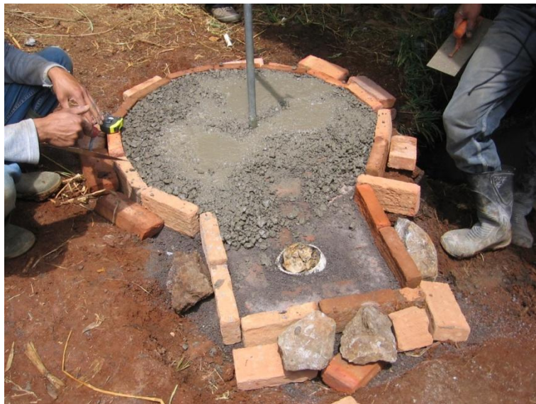
Gambar 127. Mengecor lantai dasar inlet
