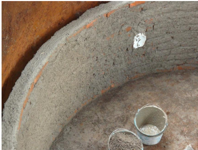
Gambar 66. Pengkamprotan dinding tangki pencerna
