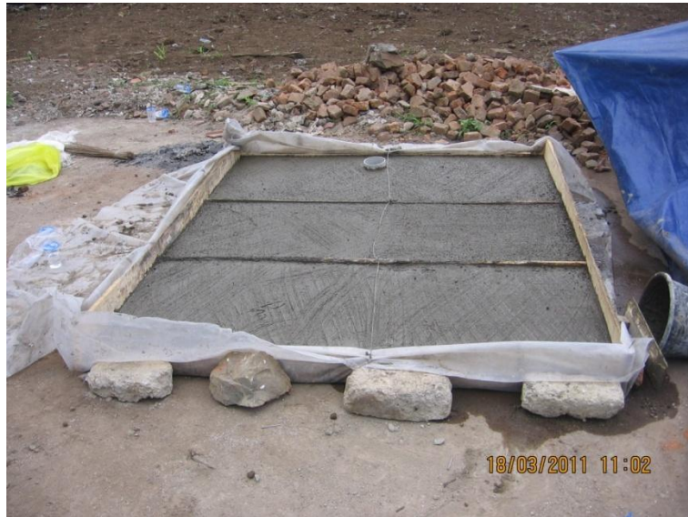
Gambar 103. Plat penutup Outlet setelah selesai dicor
