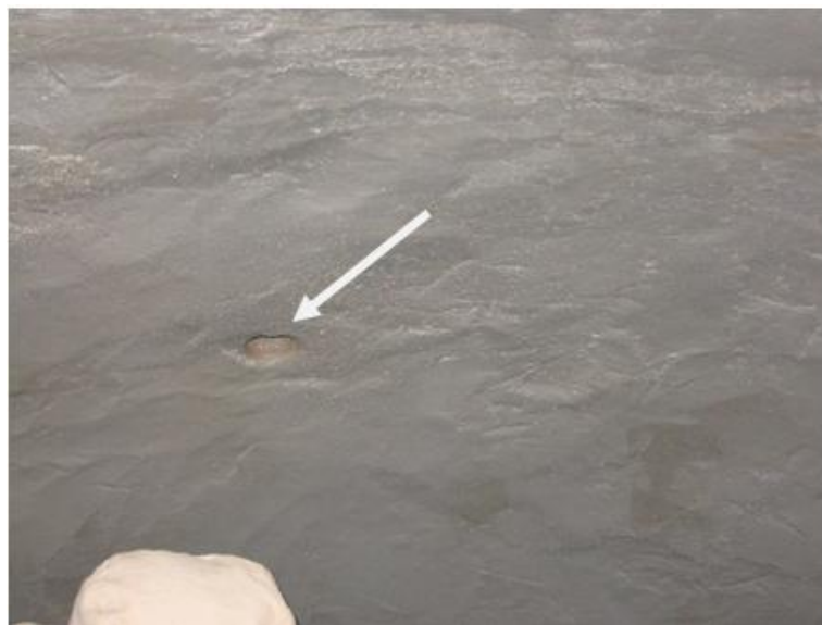
Gambar 179. Finishing lubang untuk pipa gas utama harus rapi
