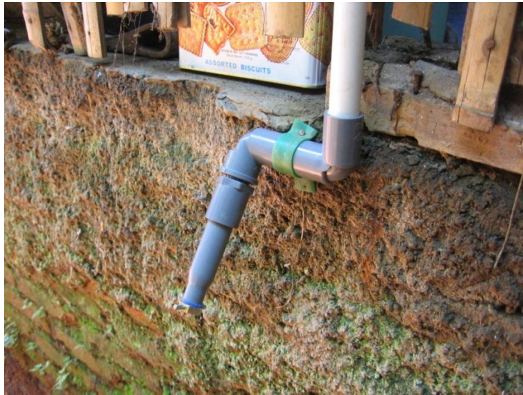
Gambar 148. Pemasangan water drain tanpa kotak
