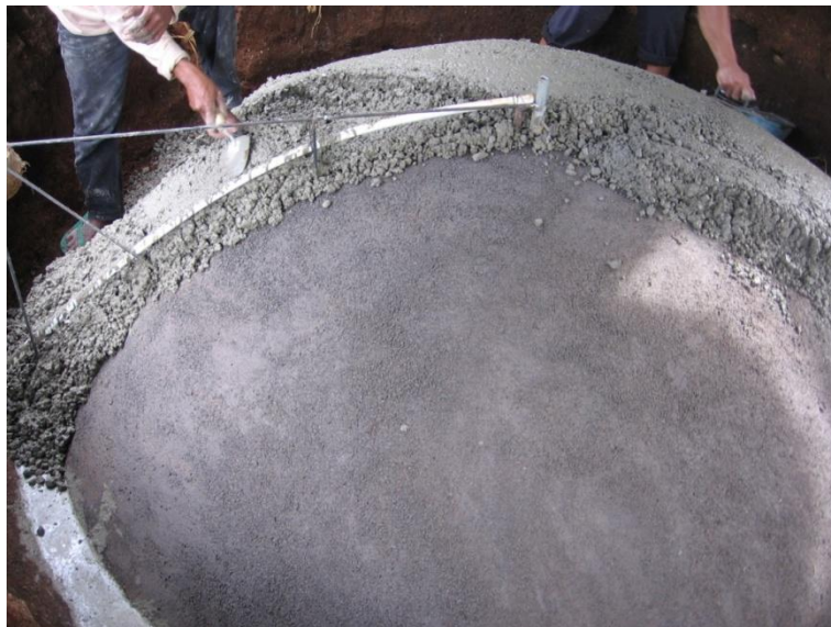
Gambar 92. Pengecoran beton bagian demi bagian
