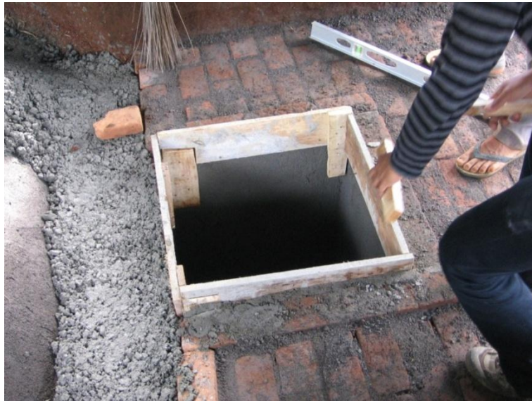
Gambar 114. Memasang bekisting untuk manhole
