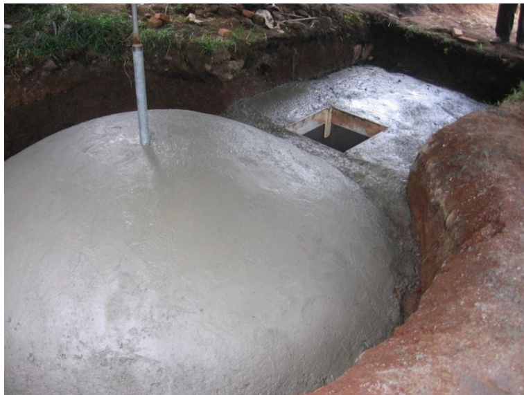
Gambar 96. Permukaan kubah setelah dirapikan
