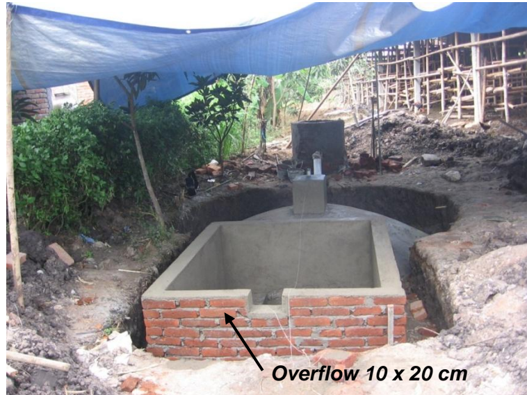
Gambar 120. Overflow pada outlet
