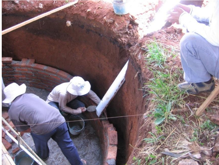
Gambar 65. Pemasangan pipainlet
