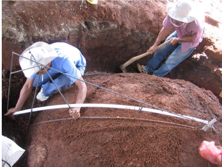
Gambar 85. Pembentukan cetakan kubah dengan mal
