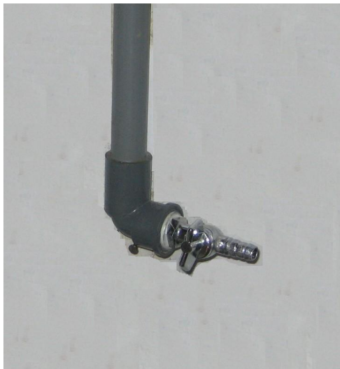
Gambar 163. Pemasangan kran gas
