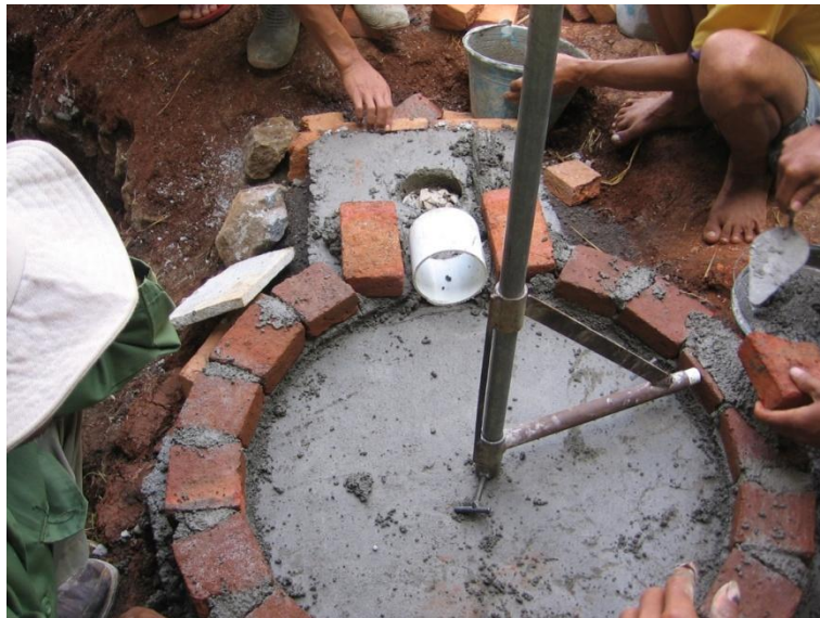
Gambar 129. Memasang bata dan pipa saluran
