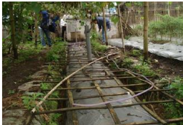
Gambar 28. Reaktor biogas yang terbuat dari plastik
