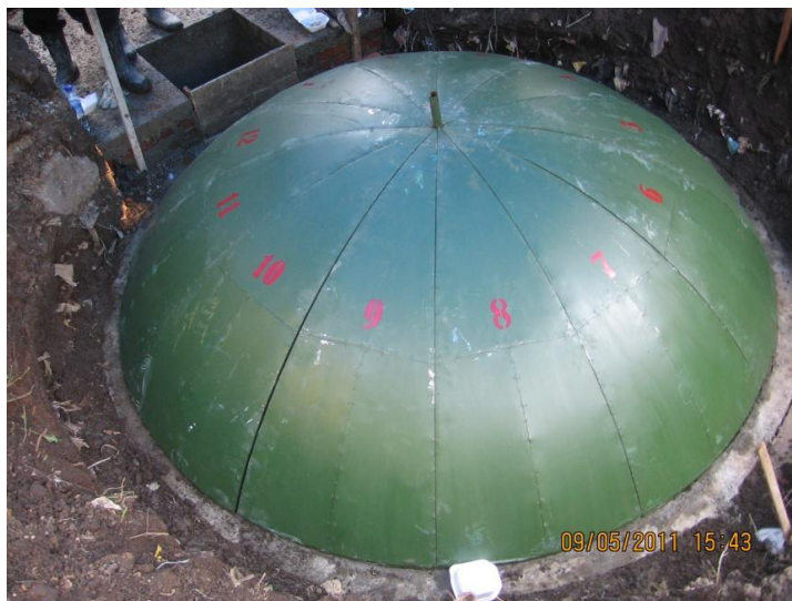
Gambar 80. Contoh cetakan kubah dari plat besi (2)
