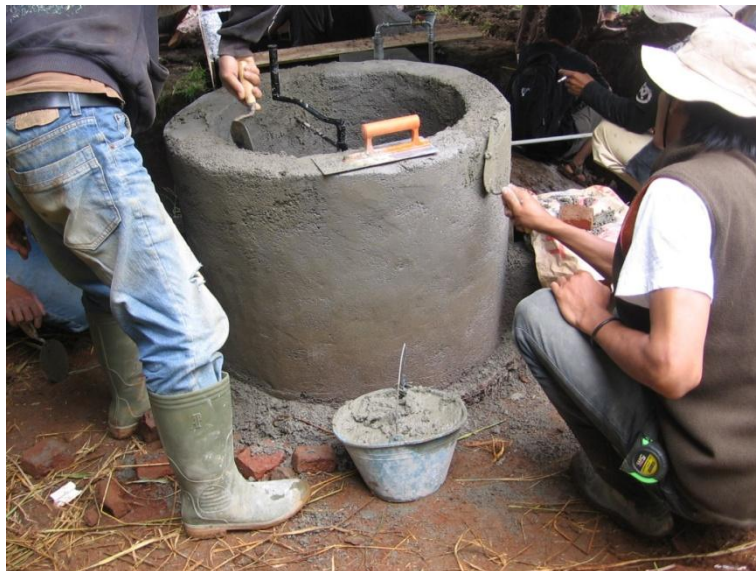
Gambar 133. Pemasangan mixer dan finishing kembali inlet
