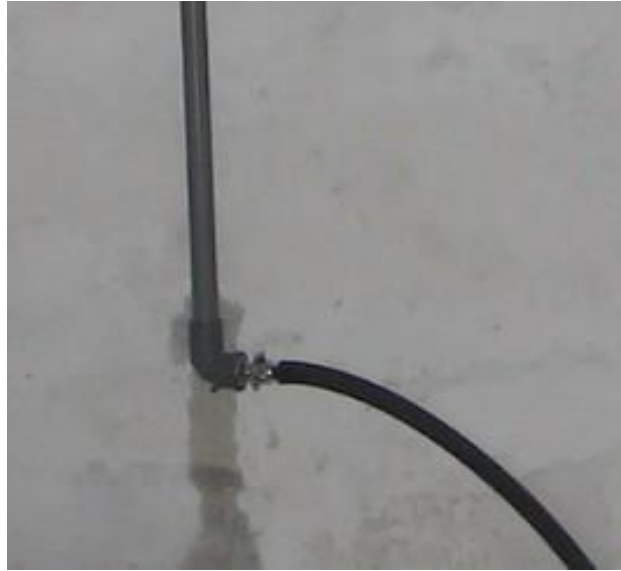
Gambar 164. Menghubungkan keran gas dengan kompor
