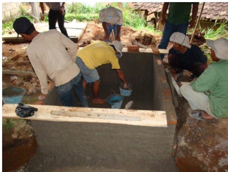
Gambar 119. Pekerjaan pemlesteran dinding Outlet
