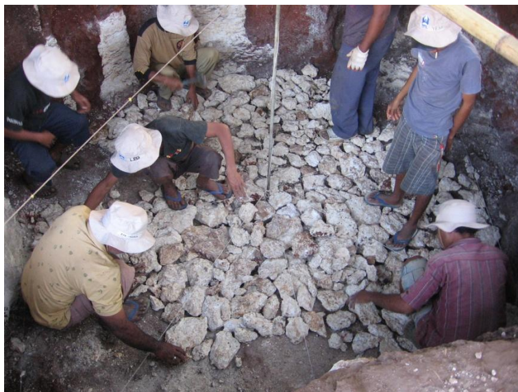
Gambar 50. Lantai kerja yang menggunakan batu kali
