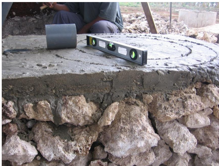
Gambar 135. Menggambar lay out inlet
