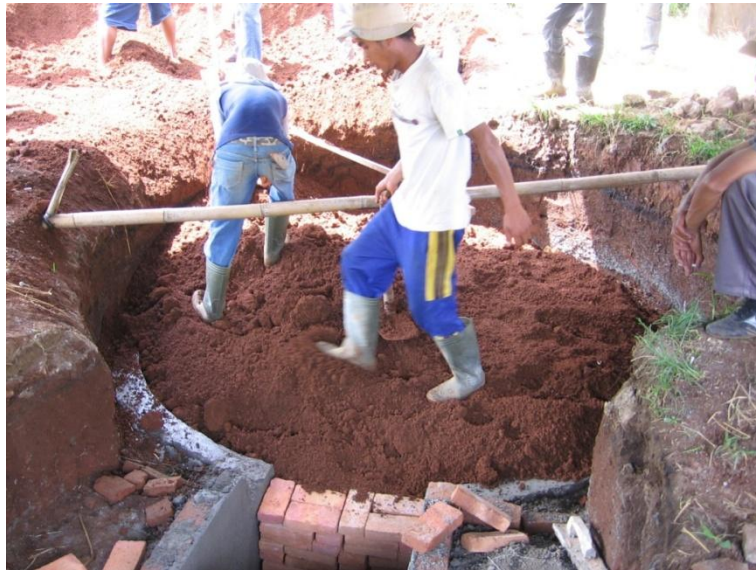
Gambar 83. Pemadatan tanah lapis demi lapis
