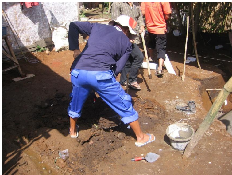
Gambar 125. Menggali tanah untuk menyesuaikan dasar inlet
