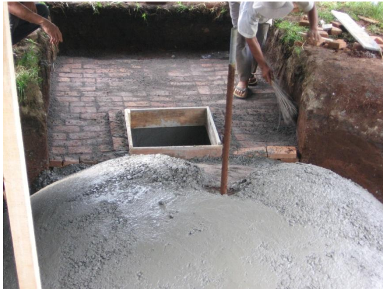
Gambar 93. Menyiapkan tempat pipa gas utama
