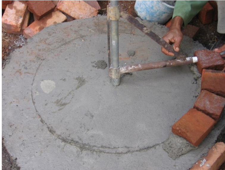
Gambar 128. Menggambar lay out inlet di atas pondasi
