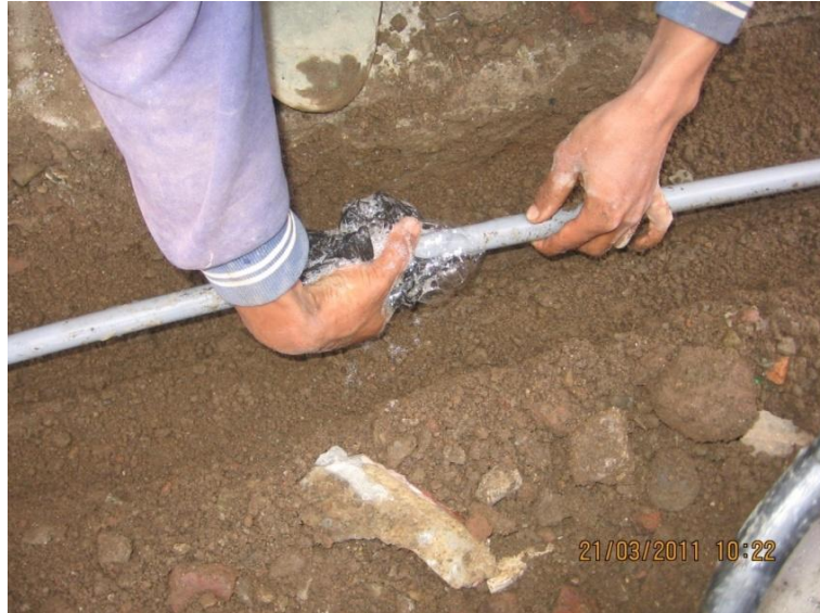
Gambar 166. Cara memeriksa kebocoran pipa pada sambungan
