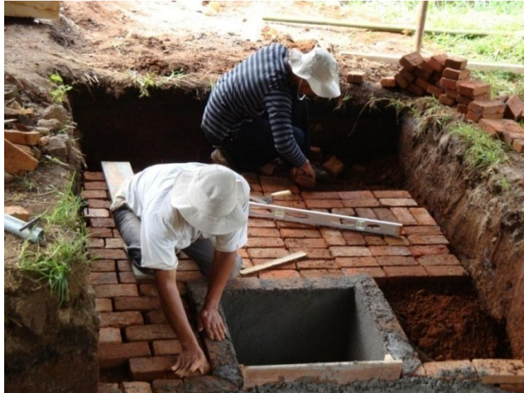
Gambar 112. Menyusun bata untuk lantai kerja
