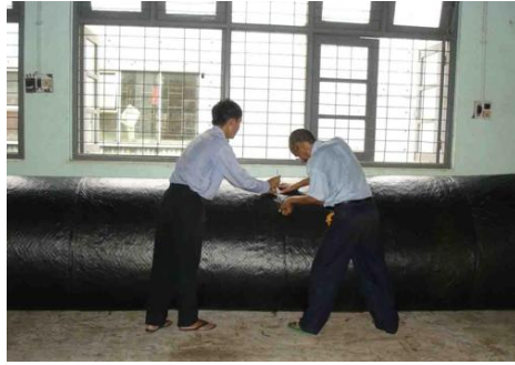
Gambar 36. Menyambung tabung reaktor
