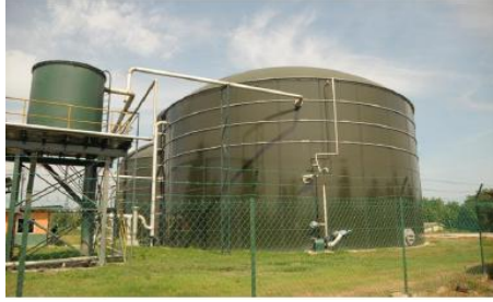
Gambar 15. Contoh reaktor biogas (Jerman)
