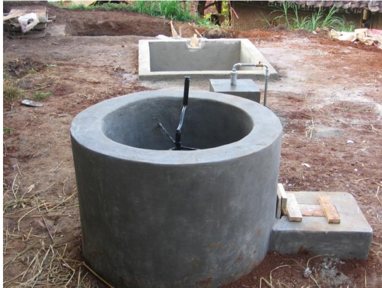
Gambar 134. Inlet yang telah siap digunakan
