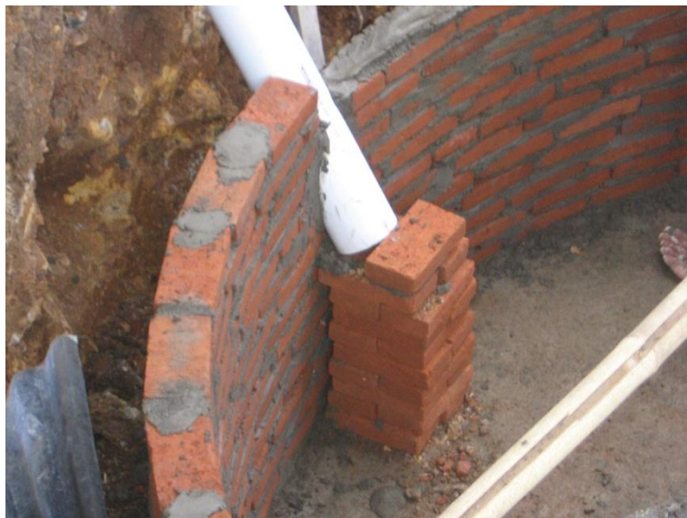
Gambar 64. Penyesuaian ketinggian pipa Inlet dari pondasi
