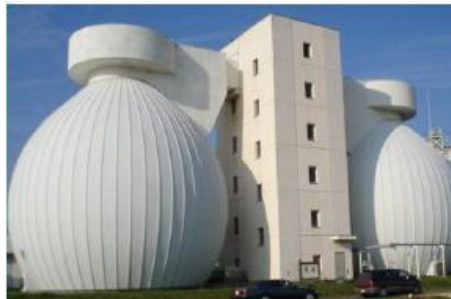
Gambar 13. Contoh Reaktor Biogas (Jepang)
