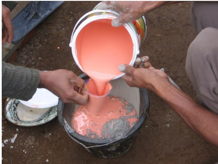
Gambar 176. Pencampuran semen dan cat acrylic
