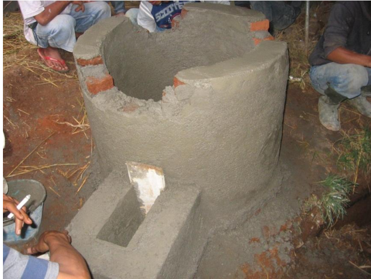
Gambar 132. Pekerjaan finishing inlet
