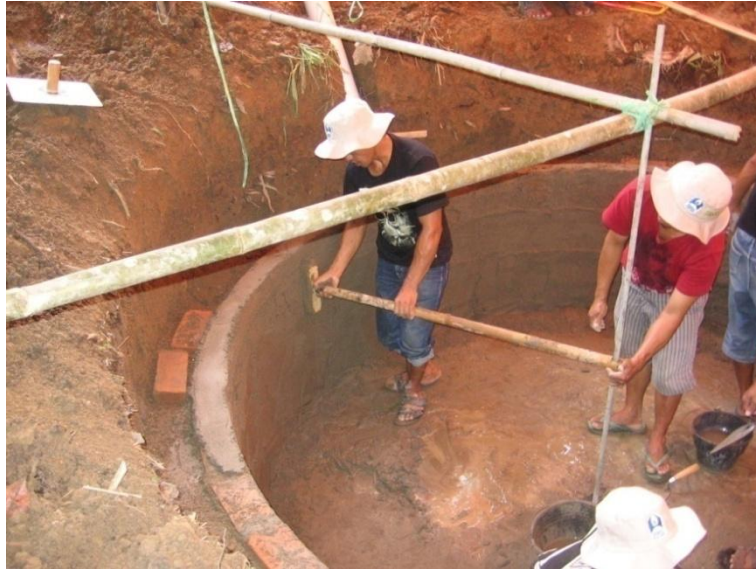
Gambar 73. Contoh mal dari bambu
