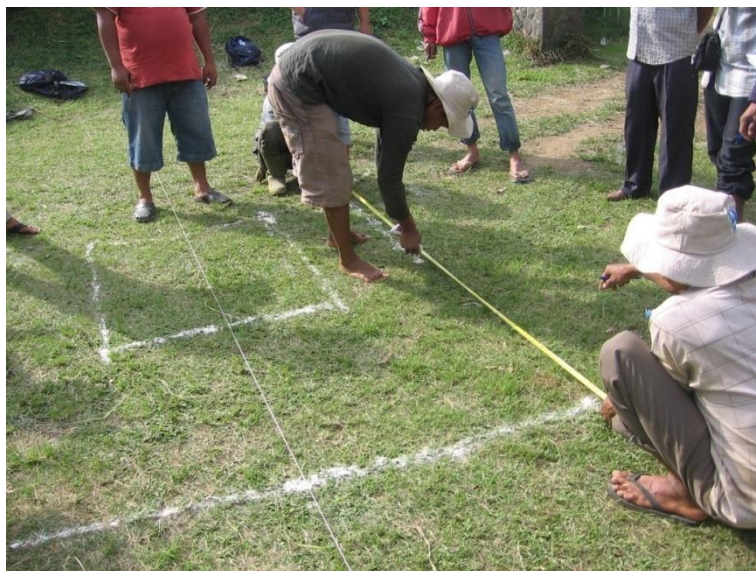
Gambar 190. Mengukur dan menandai outlet
