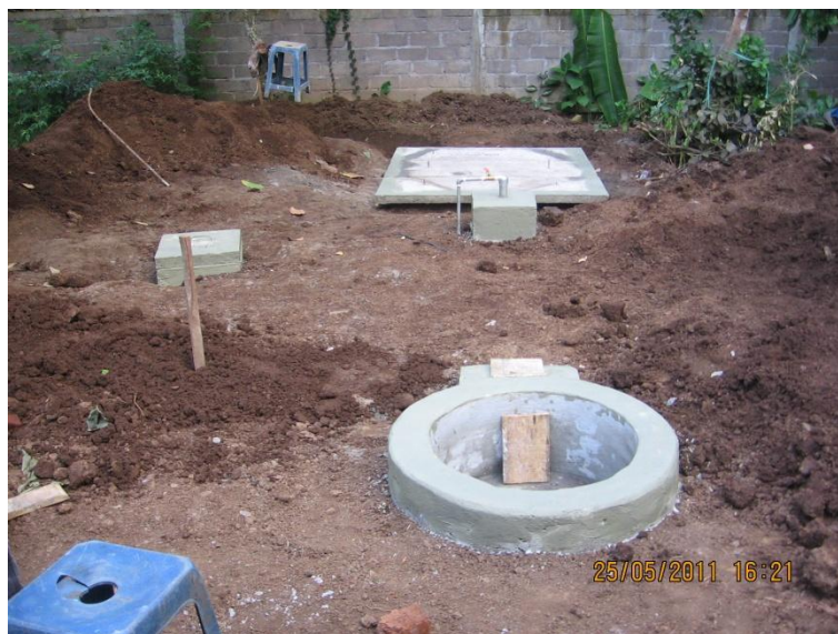
Gambar 141. Contoh inlet tanpa tandon
