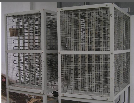
Gambar 3. 25 Beban ballast berupa elemen pemanas udara
