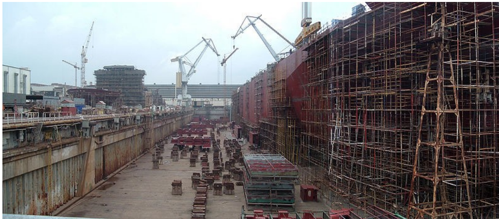
4.1 Kapal yang sedang dibangun di galangan Gdynia Shipyard
