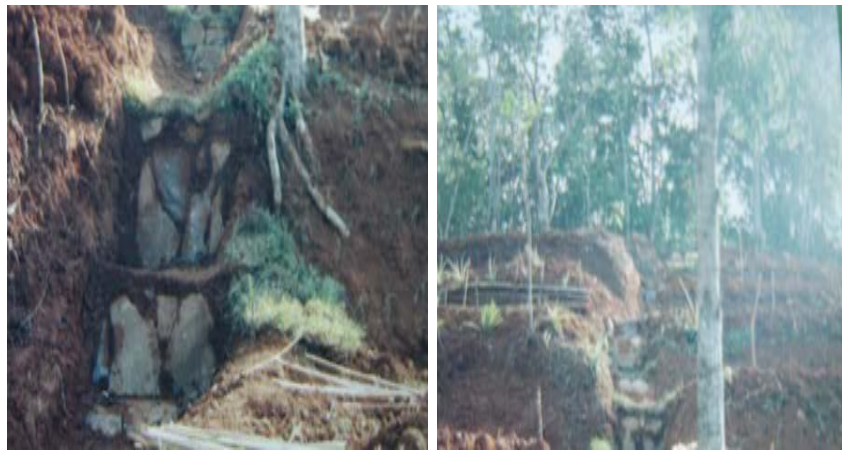
Gambar 78. Bangunan Saluran Pembuang Air (SPA) dari batu.
