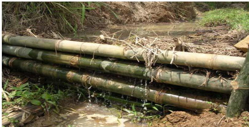
Gambar 79. Bangunan terjunan air (BTA) dari bambu
