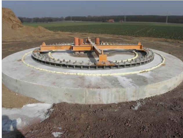
Pondasi pasca pengecoran
