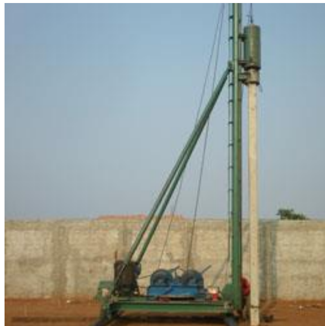
Penggerak memasukan pancang ke dalam Tanah
