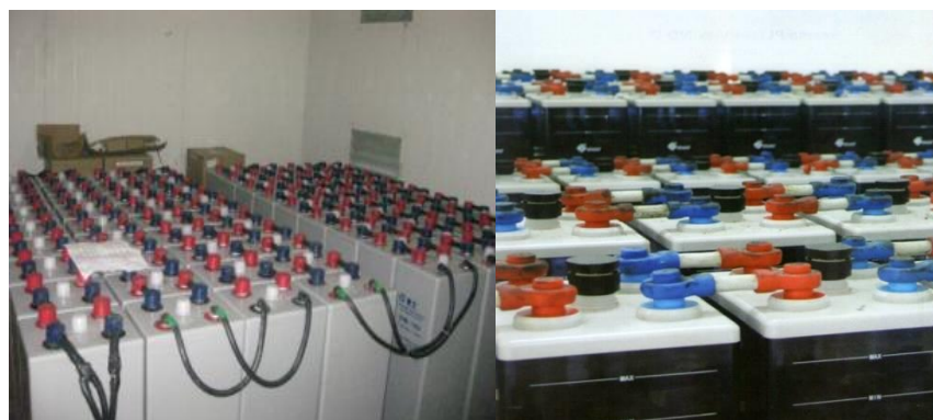
Gambar 7. 11 Contoh hubungan serial dan paralel pada baterai
