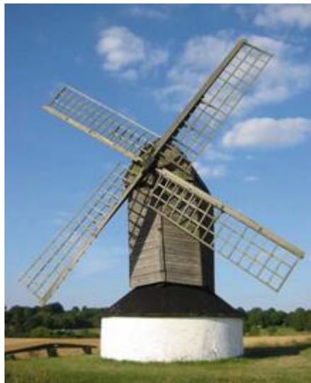
*Mills* ini dibangun dengan struktur baik. Menara berbentuk bulat atau *polygonal* dan dibangun dari kayu atau batu. Rotor secara manual dihadapkan ke arah angin dengan bantuan ekor. *Mills* dijaga saat menghadang angin kencang dengan memindahkan kanvas pelindung rotor.
