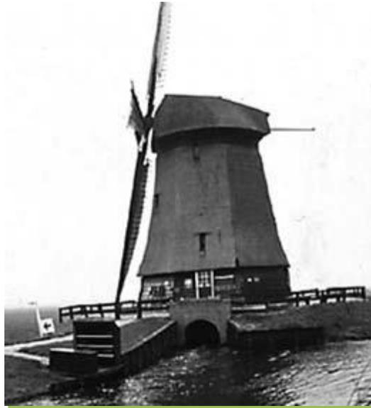
Gambar 4.2. menunjukkan bahwa *windmills* di atas memiliki rotor yang relatif kecil dengan diameter berkisar satu meter hingga beberapa meter. Tujuan utama yaitu memompa air setinggi beberapa meter di bawah permukaan lahan pertanian. Pemompa air ini, dengan sudu yang terbuat dari bahan logam dan desain teknik yang lebih baik sehingga meningkatkan produktifitas pertanian.
