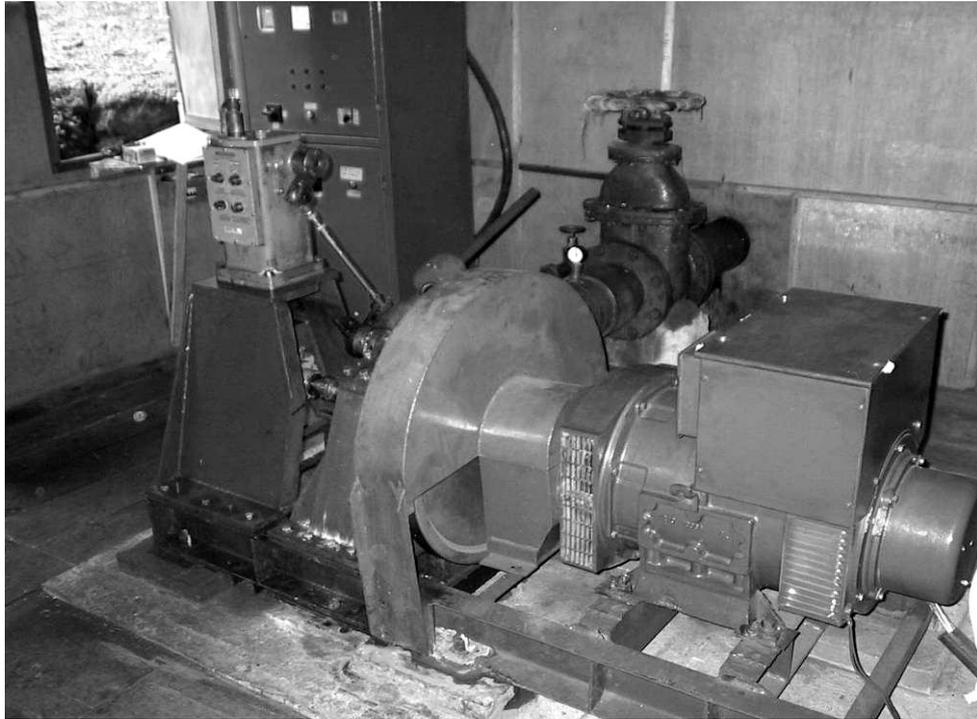
**Gambar 6. 4 Contoh Tengpoche: Generator yang dihubungkan langsung dengan flywheel pada shaft turbin dan kontrol mekanis yang dihubungkan dengan gearbox**
