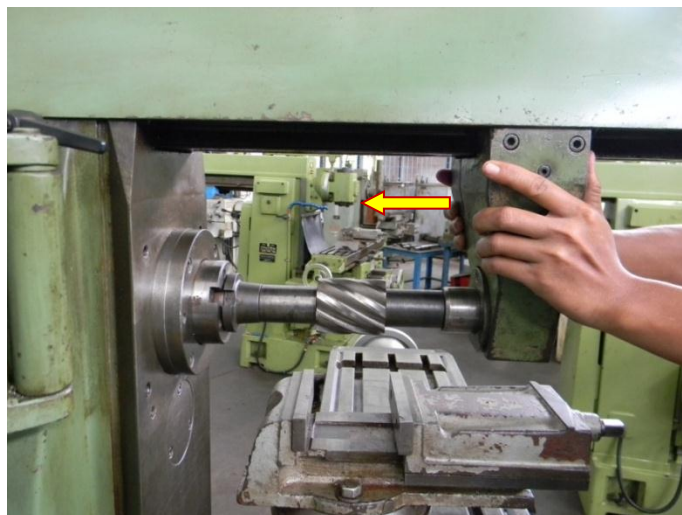
Gambar 3. 32 Pemasangan pendukung arbor
