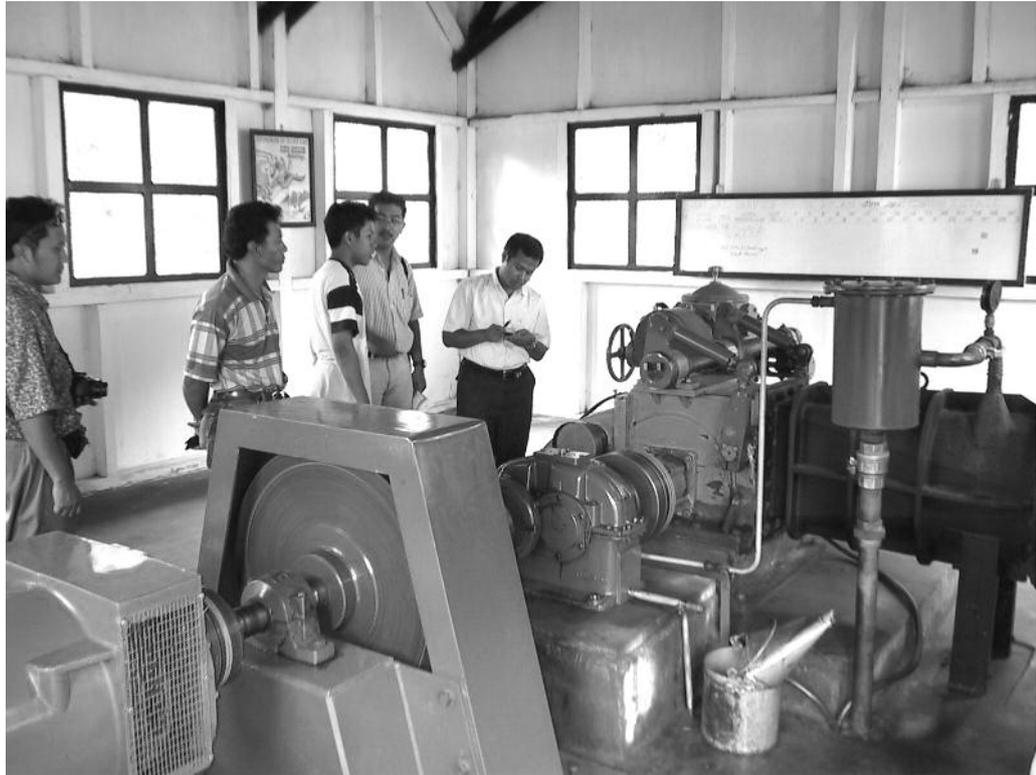
**Gambar 2. 35** Generator yang dihubungkan tidak langsung menggunakan gear box
