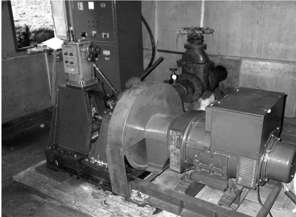
**Gambar 2. 32 Contoh Tengpoche: Generator yang dihubungkan langsung dengan flywheel pada shaft turbin dan kontrol mekanis yang dihubungkan dengan gearbox**
