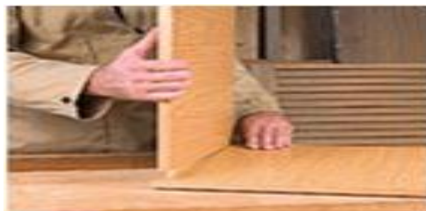
Gambar 7.25 Cara merangkai sambungan sudut
