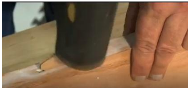
Gambar 7.24. Cara memasang isian lamello
