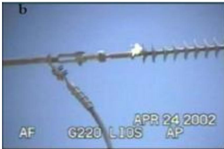
Gambar 4 Insulator yang Tidak Terpasang Korona Ring
