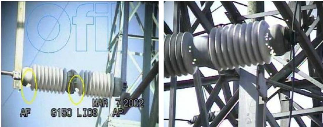
Gambar 8 *Gap discharge* pada insulator
