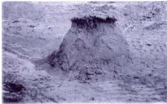
Gambar di atas menunjukkan sebidang tanah yang disiapkan untuk suatu bangunan. Pemborong dengan sengaja meninggalkan timbunan tanah. Tahukah Anda bahwa tujuannya adalah memperkirakan volume tanah yang diambil dari areal tersebut?
