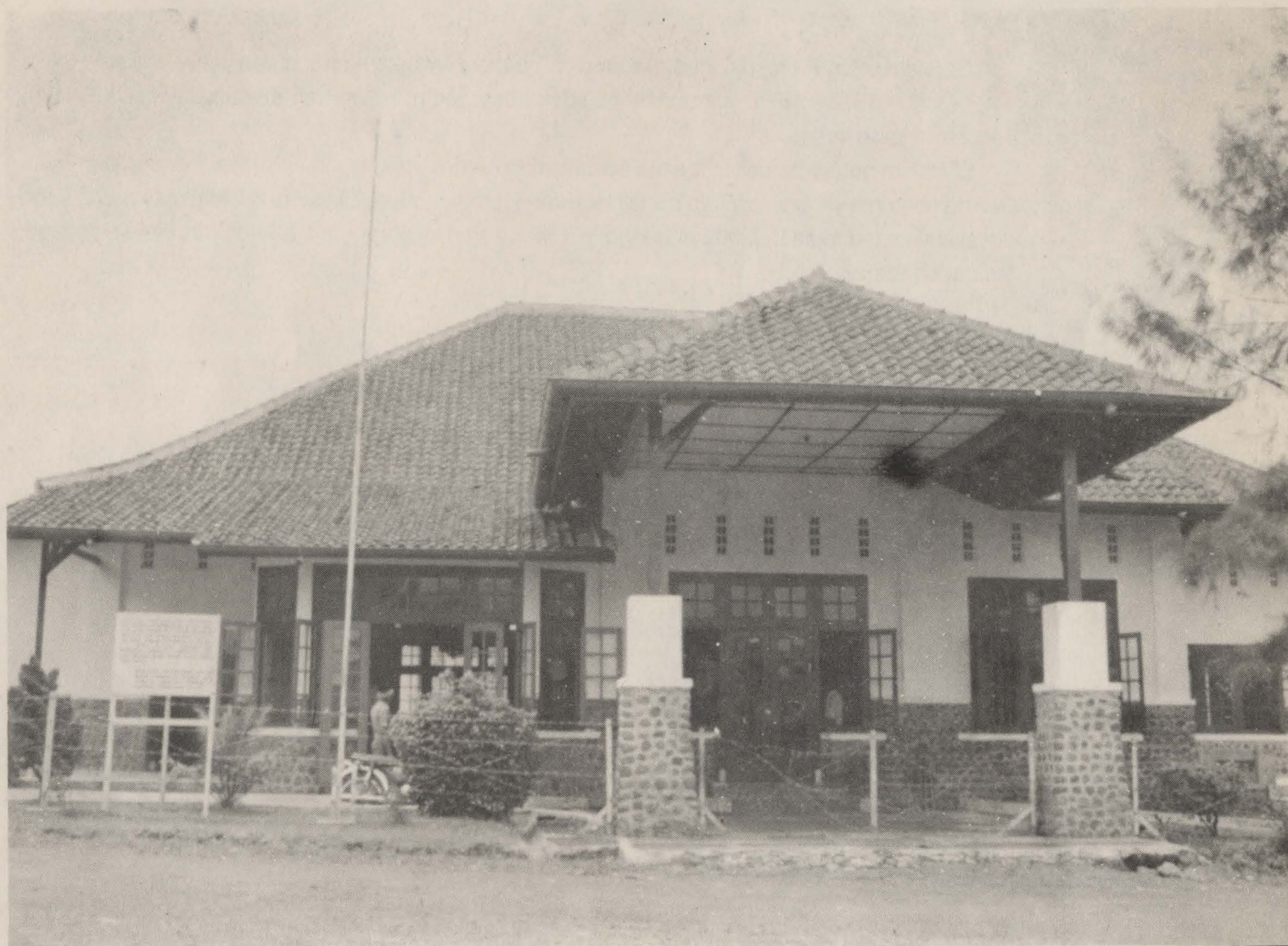
87. Gedung Perundingan Linggajati
