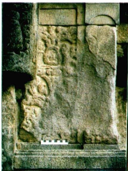
Gambar 3.10 Hilangnya relief akibat pengelupasan kulit bawang yang sangat intensif
