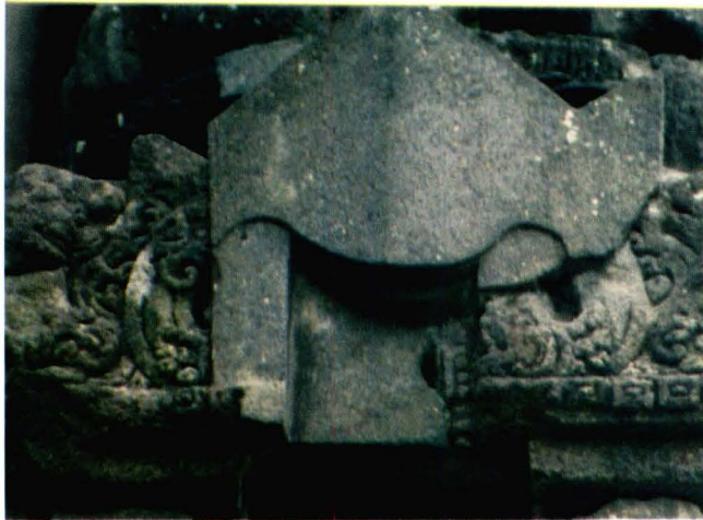
Gambar 3.18 Restoring menggunakan pengganti batu baru
