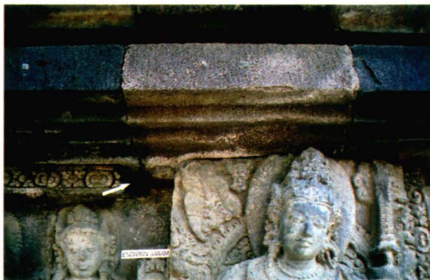
Gambar 3.17 Pengelupasan karena endapan garam
