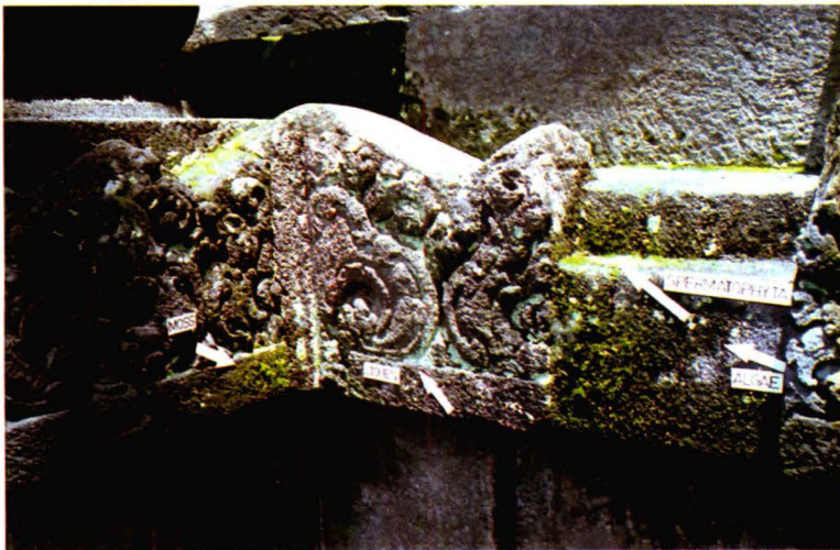
Gambar 3.4 Pertumbuhan mikroorganisme pada permukaan batu candi
