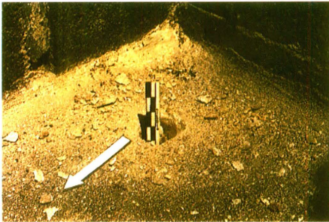
Gambar 3.44 Mortar semen untuk menambal cekungan pada bingkai rata
