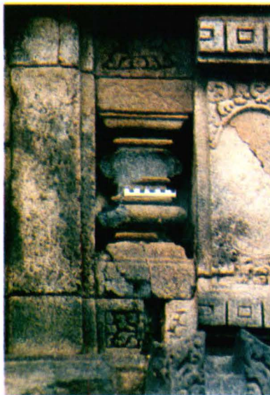
Gambar 3.12 Pengausan akibat pelapukan mengulit bawang pada bentang antefik di Candi Siwa
