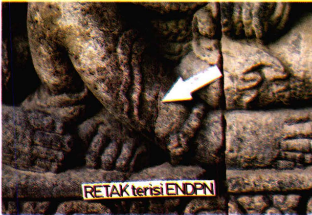
Gambar 3. 7 Retakan Berisi Endapan
