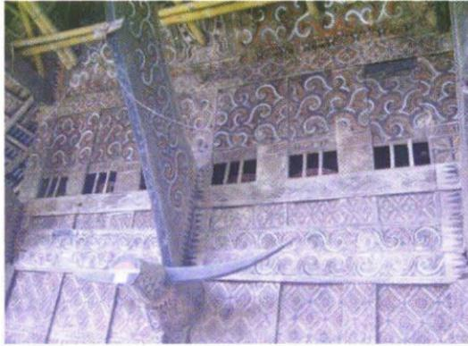
Foto 6. Tampak 6 buah ventilasi (*sulewa*) pada dinding bagian depan *banua layuk*
