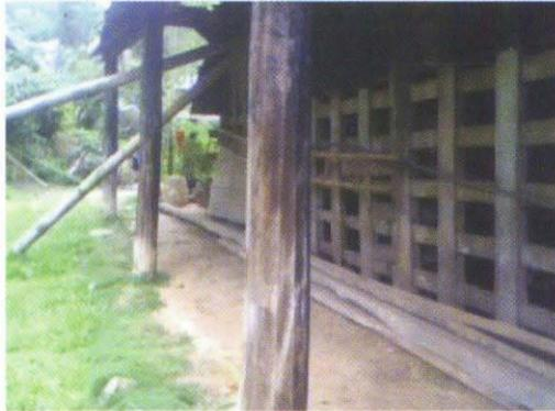
Foto 20. Profil tiang-tiang bundar (*ossok pamiring*) sebagai penyanggah atap pada sisi kanan bagian bawah dari *banua layuk*.
