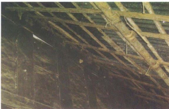
Foto 61. Tampak konstruksi pemasangan rangka atap pada *banua layuk*.
