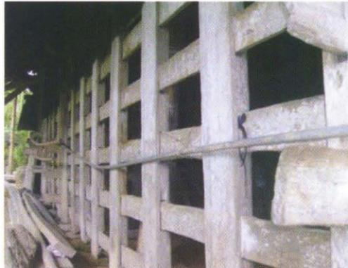
Foto 19. Tampak deret tiang penyanggah lantai (*lentong*) pada *banua layuk* yang pemasangannya dilakukan dengan sistem sambung menyambung antara satu dengan yang lainnya melalui beberapa susun pasak (*pelelen*)
