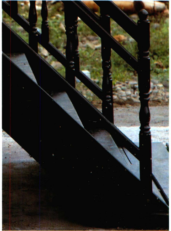
Foto 16 : Teknik pemasangan anak tangga yang sebagian ujungnya dipasang tembus ke sisi induk tangga kemudian dikuatkan dengan pasok .
