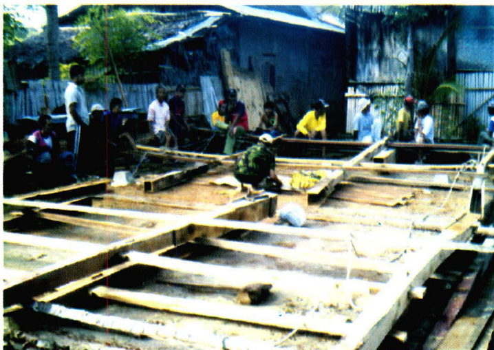
Foto 7 : Beberapa tiang yang telah ditolor di atas areal yang akan dibangun rumah. Deretan yang terdapat possi arriang diletakkan pada bagian atas.
