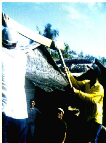
Foto 12 : Pemasangan passanna dilakukan pada setiap tiang di bawah pasak ( aratang, passollor dan baeq ), dimaksudkan untuk menguatkan pasak tersebut agar tidak goyang.
