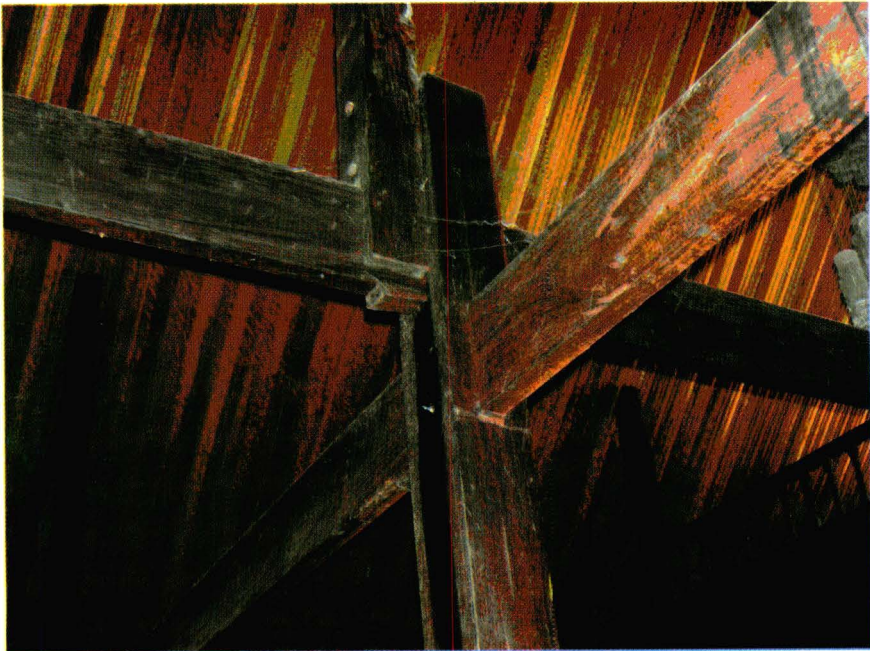
Foto 15 : Teknik pemasangan arriang sudduq yang bertumpu pada baeq .
