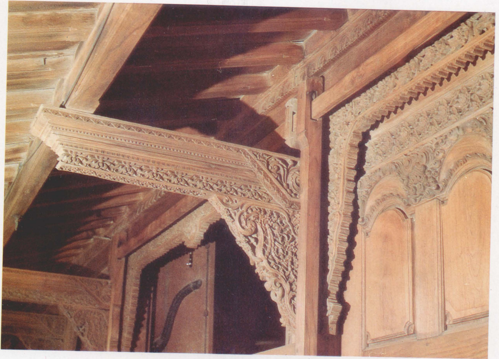
Detail rumah adat Jawa Tengah, sistem lereg pada pintu kere.
