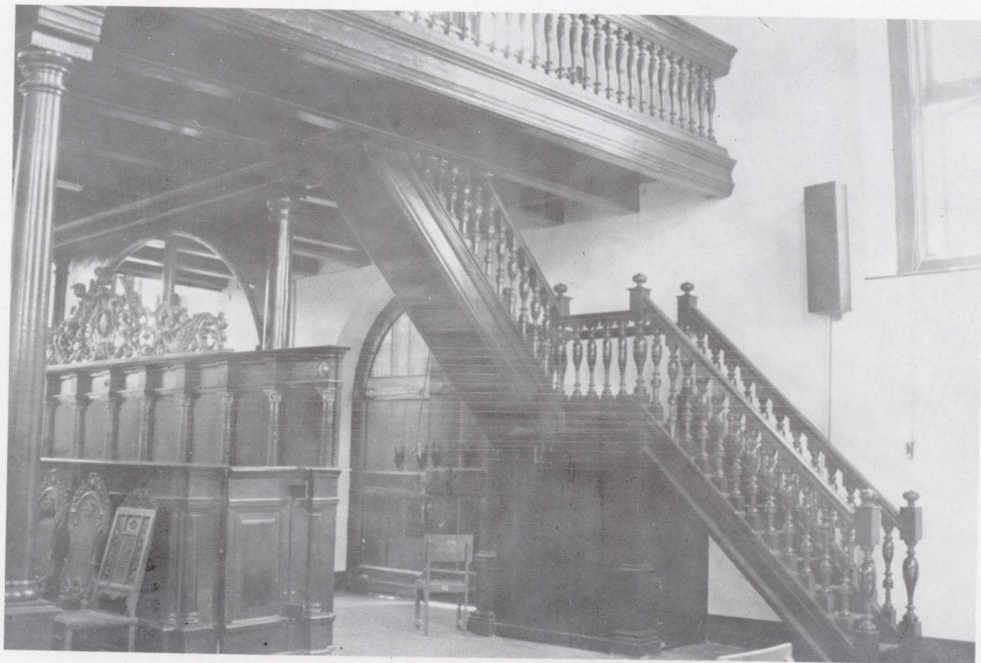
Tangga untuk naik ke balkon pada ruang dalam Gereja Sion di bagian Utara. A staircase goes to the balcony of the Sion church's interior in the north side of the building.
