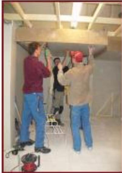
Gambar 2.7. Memasang Rangka Plafon Bangunan
