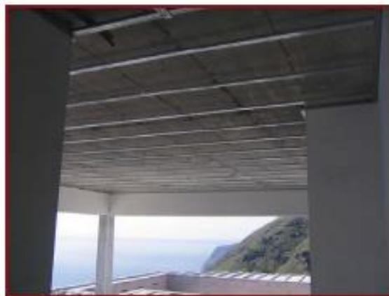
Gambar 2.7. Rangka Plafon Bangunan
