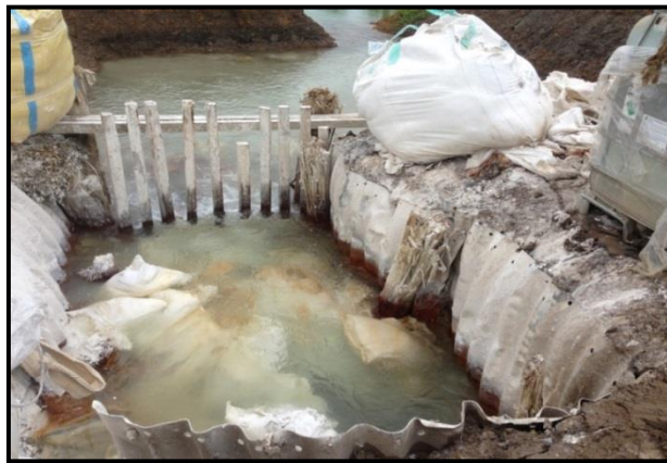
Gambar 13. Pemberian Kapur pada Saluran Terbuka (PT.Trubaindo Coal Mining, Kalimantan Timur, 2015)
