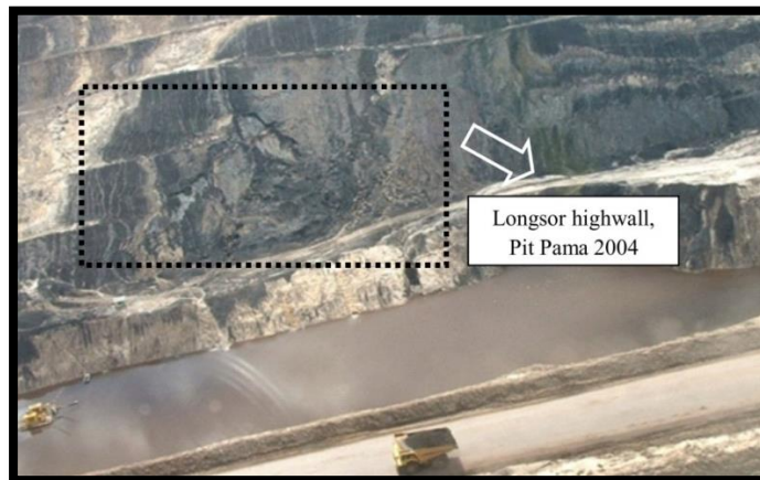
Gambar 99. Longsoran di Tambang Batubara Adaro (Saptono, 2008)
