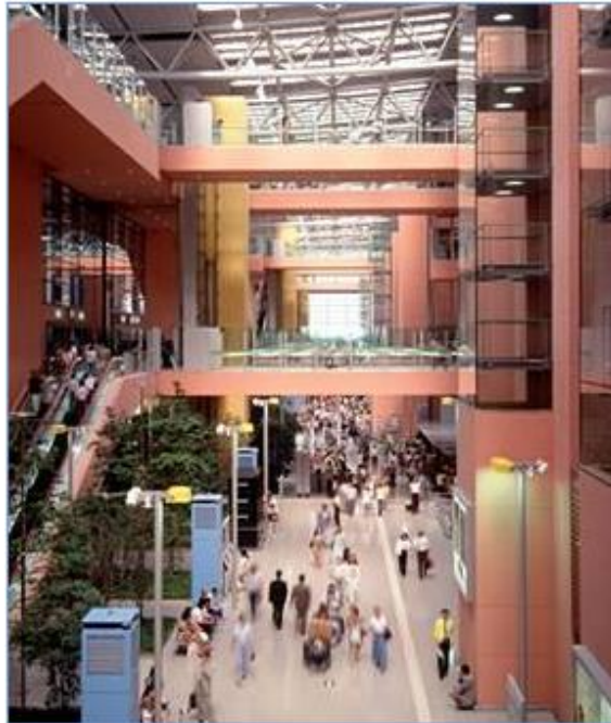
Gambar 5.1. Balok pada Kansai International Airport, Osaka - Jepang
