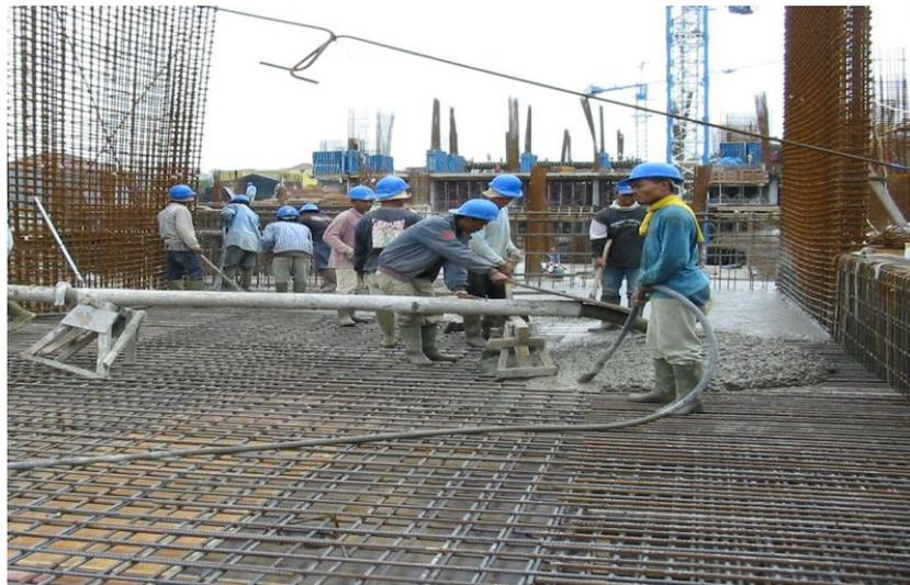
Gambar 3.3.25. Pekerjaan Pengecoran Plat Lantai
