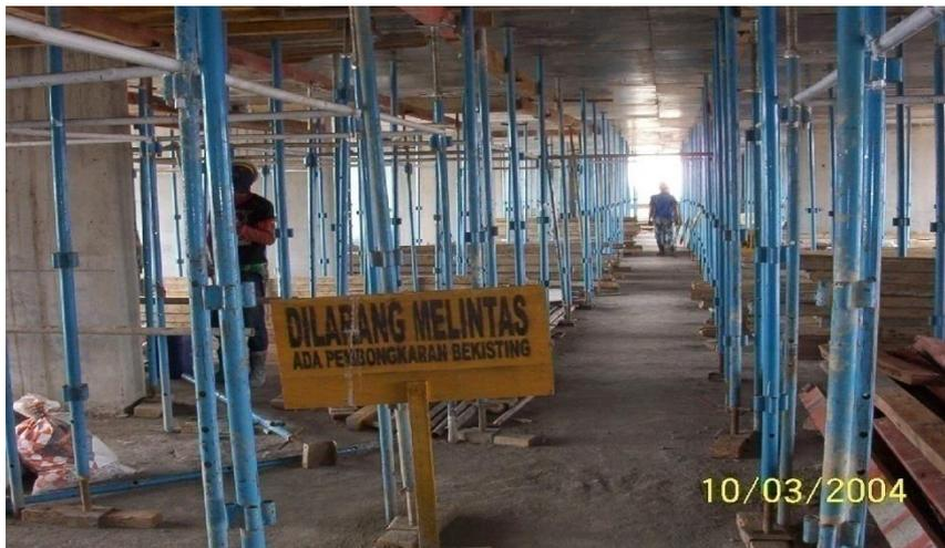
Gambar 3.3.21. Rambu-Rambu Pada Pekerjaan Bekisting
