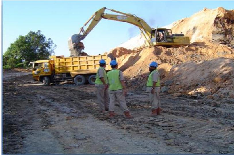
Gambar 3.3.13. Excavator pada Pekerjaan Tanah Mekanis
