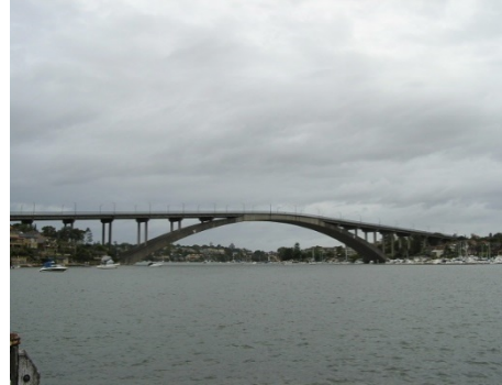
Gambar 100. Lengkung jembatan berbentuk parabola
