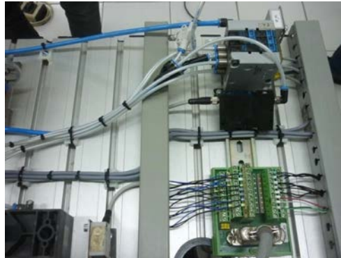
Gambar 72. Instalasi tubing dan kabel
