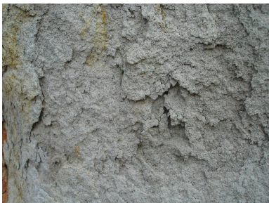
Contoh pelapukan secara fisis pada batu dan bata
