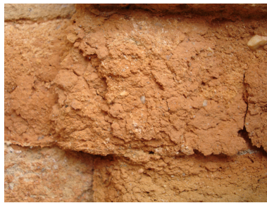
Contoh pelapukan secara fisis pada batu dan bata
