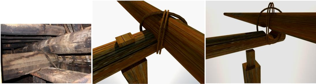
Gambar 2.18 Detail Sistem Sambungan Purus dan Lubang dengan pengikat tali pada bagian kolom dan balok
