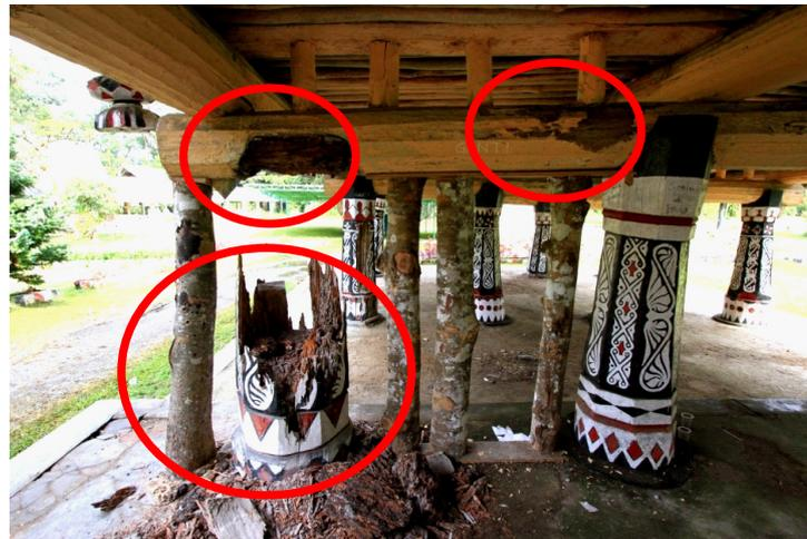
Foto 2.5 Pelapukan yang parah pada bagian tiang kolom dan balok Rumah Bolon
