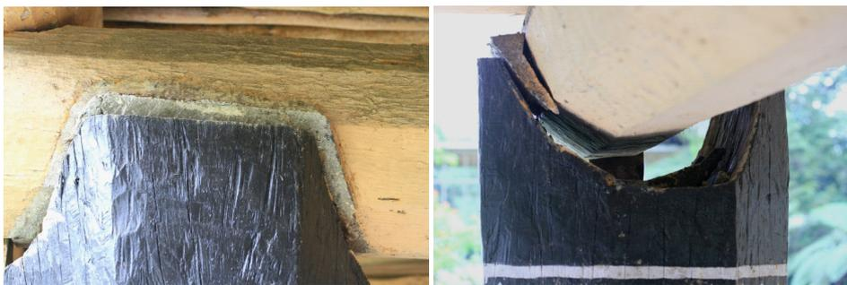
Foto 2.7 Kerusakan Dislokasi/Deformasi pada join tiang kolom dan balok Galang
