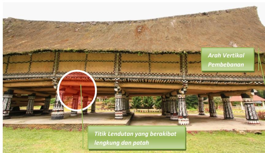
Foto 2.8 Ilustrasi Pembebanan yang menyebabkan kemelesakan dan patahan
