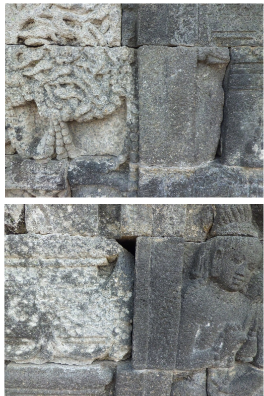
Gambar 8. Relief pada batu yang mengalami penggaraman dan yang tidak
