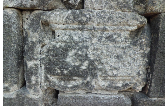
Gambar 4. Penggaraman pada batu Candi Borobudur
