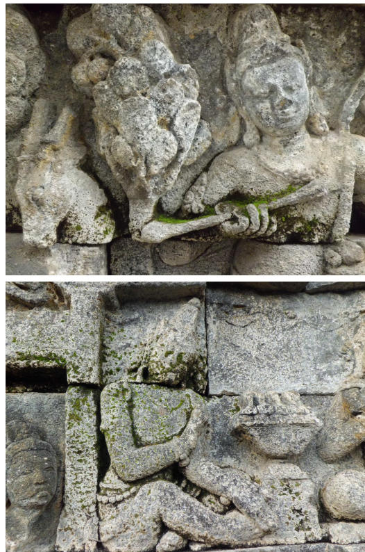
Gambar 9. Pertumbuhan lumut pada blok batu yang mengalami penggaraman
