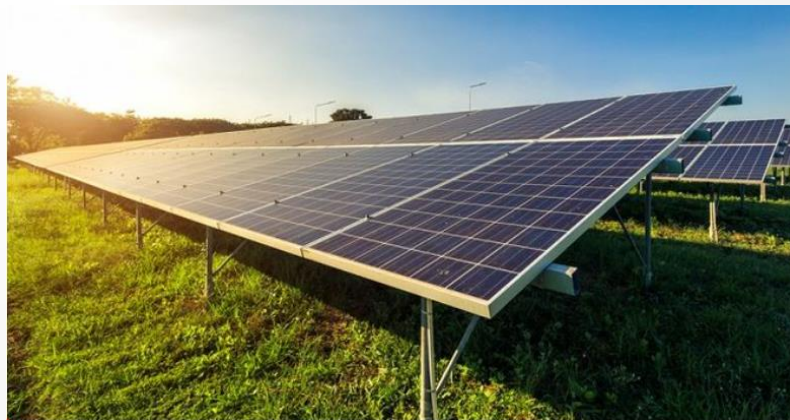
Gambar 15. Pemasangan Sel Surya
