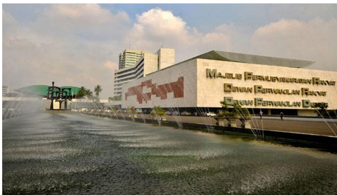
Gambar 5.7. Gedung MPR, DPR, dan DPD di Senayan Jakarta
