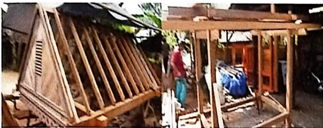
Gambar 6 Rangka Bongkar Pasang Umah Using
