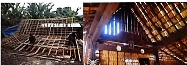
Gambar 7 Rangka Langit-langit Umah Using
