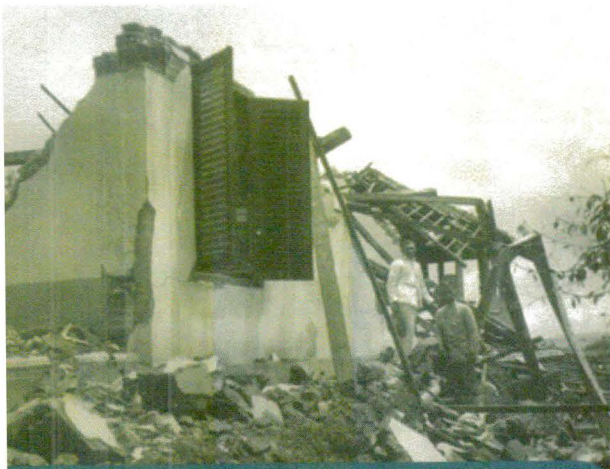
Gambar 11. Bangunan hancur akibat gempabumi Wonosobo tahun 1924 (Sumber: https://digitalcollections.universiteitleiden.nl/ )
