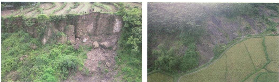
**Gambar 5.** Longsor runtuhan (*rockfall*) di Desa Ngebung sebelah utara gardu pandang (gambar kiri) dan tipologi longsor kompleks di dekat aliran sungai (gambar kanan) (sumber : survei lapangan 2019)
