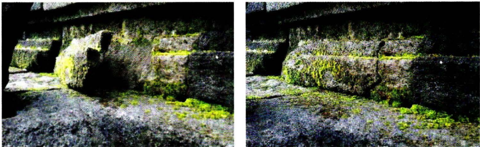
Foto A-7. Batu yang pecah pada sisi Selatan tingkat 4 bidang a tampak dalam
