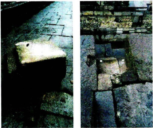
Foto A-6. Batu penyusun pagar langkan yang jatuh
