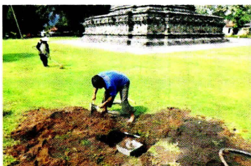
Foto B-3. Proses pemasangan patok pengukuran di Candi Mendut
