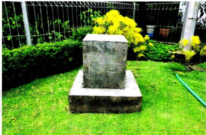
Gambar B-1. Desain patok pengukuran sesuai dengan SNI
