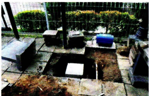
Foto B-4. Proses pemasangan patok pengukuran di Candi Pawon
