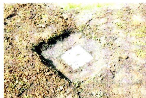
Foto B-3. Proses pemasangan patok pengukuran di Candi Mendut
